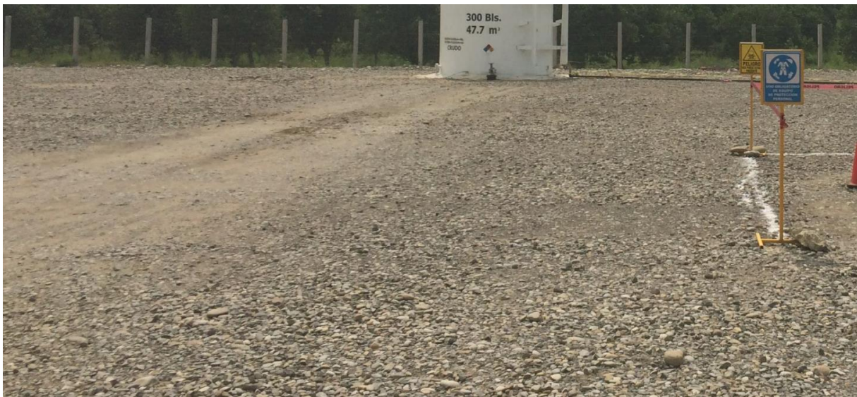
Figura 3. Ejemplo de conclusión de trabajos de preparación de sitio
