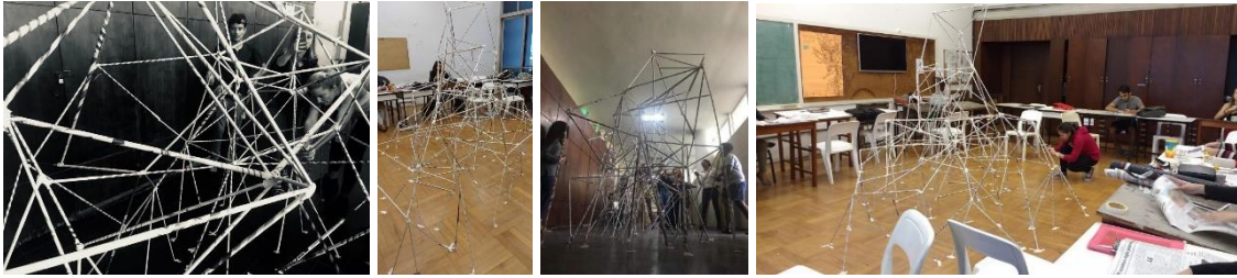
Figuras 8, 9, 10 e 11: A estrutura em processo de construção pelos cursistas
