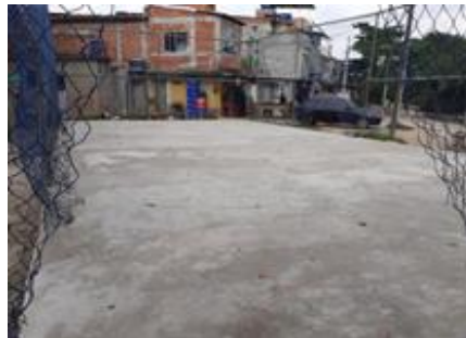
Figura 6. Quadra incompleta com proteção danificada; imagem registrada durante a visita técnica.
