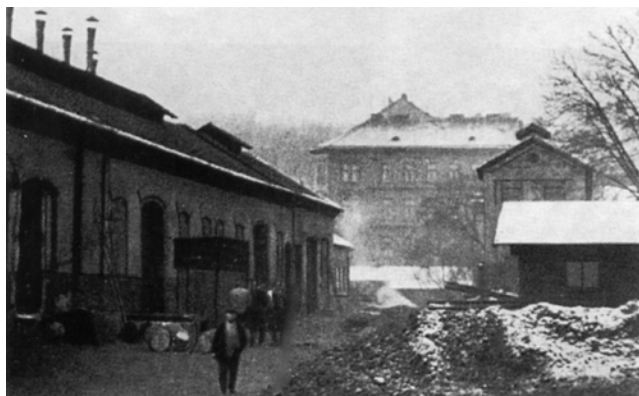
Provozní budovy smíchovské plynárny se nacházely přesně v místě, kde dnes stojí Ženské domovy
