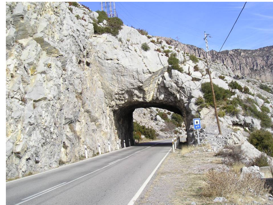
FOTOGRAFÍA 1. Afloramiento de calizas al inicio del proyecto.
