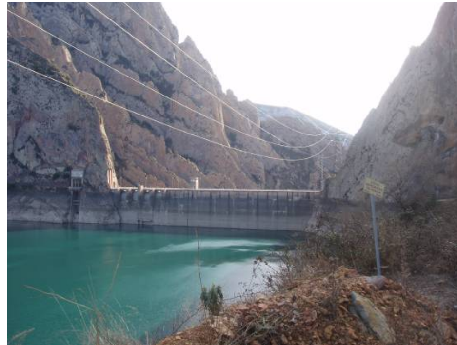
FOTOGRAFÍA 26. Ejemplo de UNIDAD PAISAJÍSTICA 4. Embalse de Escalles, en el T.M. de Sopeira.
