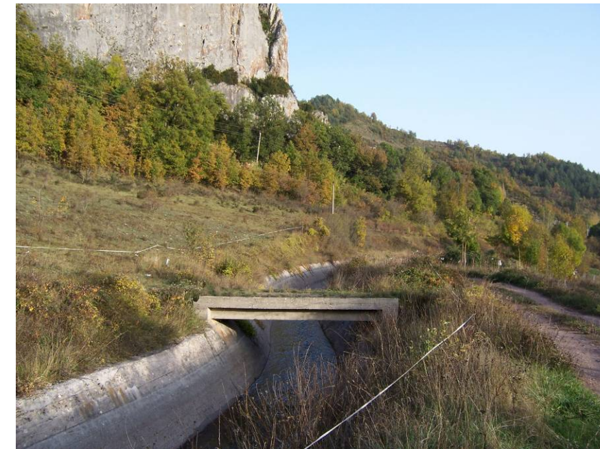
FOTOGRAFÍA 42. Canal afectado por el trazado, en el TM de El Pont de Suert. La nueva carretera cruzará el canal en este punto (PK 113+760 aproximadamente).
