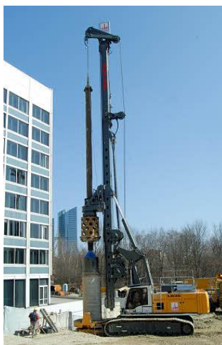
1.2. ábra. A Liebherr által gyártott cölöpverő gép
