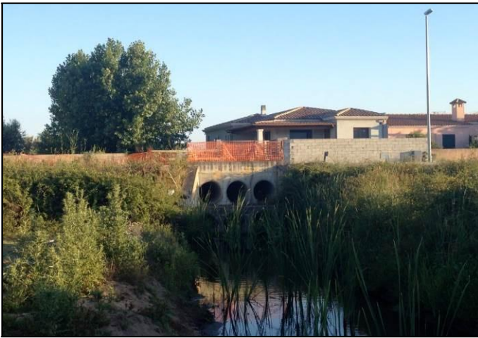
Figura 34. Vista dell’area di laminazione “VSN_2” verso valle prima dell’abitato (sin), si noti l’attuale tombino che in sostanza già oggi regola la laminazione dell’area naturalmente e vista verso monte (dx)
