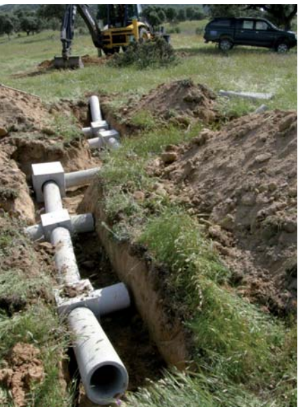
Figura 7.31. Proceso constructivo de un majano subterráneo de tubos.
