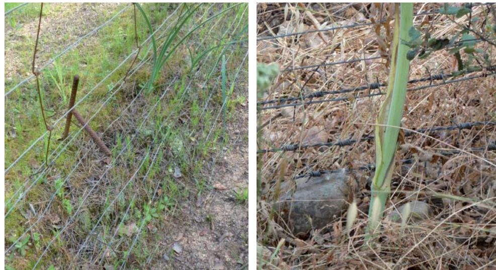
Figura 6.22. Elementos de refuerzo de vallados no autorizados: gancho y triple alambre de espino reforzando la parte en contacto con el suelo de un vallado cinegético en el área de distribución del lince.
