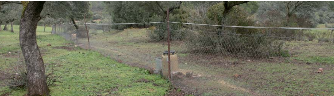
Figura 7.40. Cercado de repovoamento em área de presença estável de lince ibérico, com rede de simples torsão, rede coelheira na parte baixa e uma banda eletrificada na parte superior.
