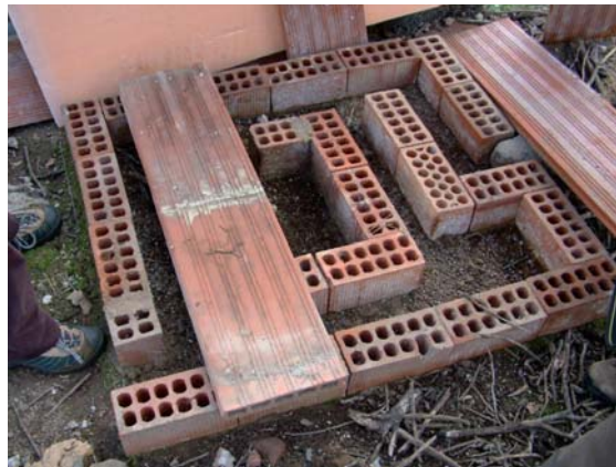
Figura 7.28. Vivar de ladrillos con parte inferior de malla electrosoldada.
