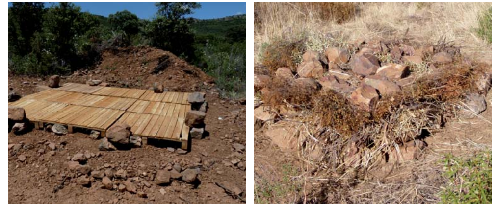
Figura 7.19. y 7.20. Proceso constructivo de majano de varios pisos y majano de palets y piedra terminado.
