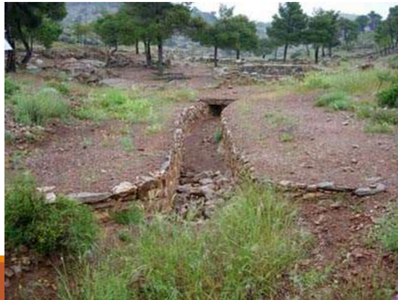
Κανάλι που κατευθύνει το νερό από την πλαγιά του βουνού στην στέρνα
