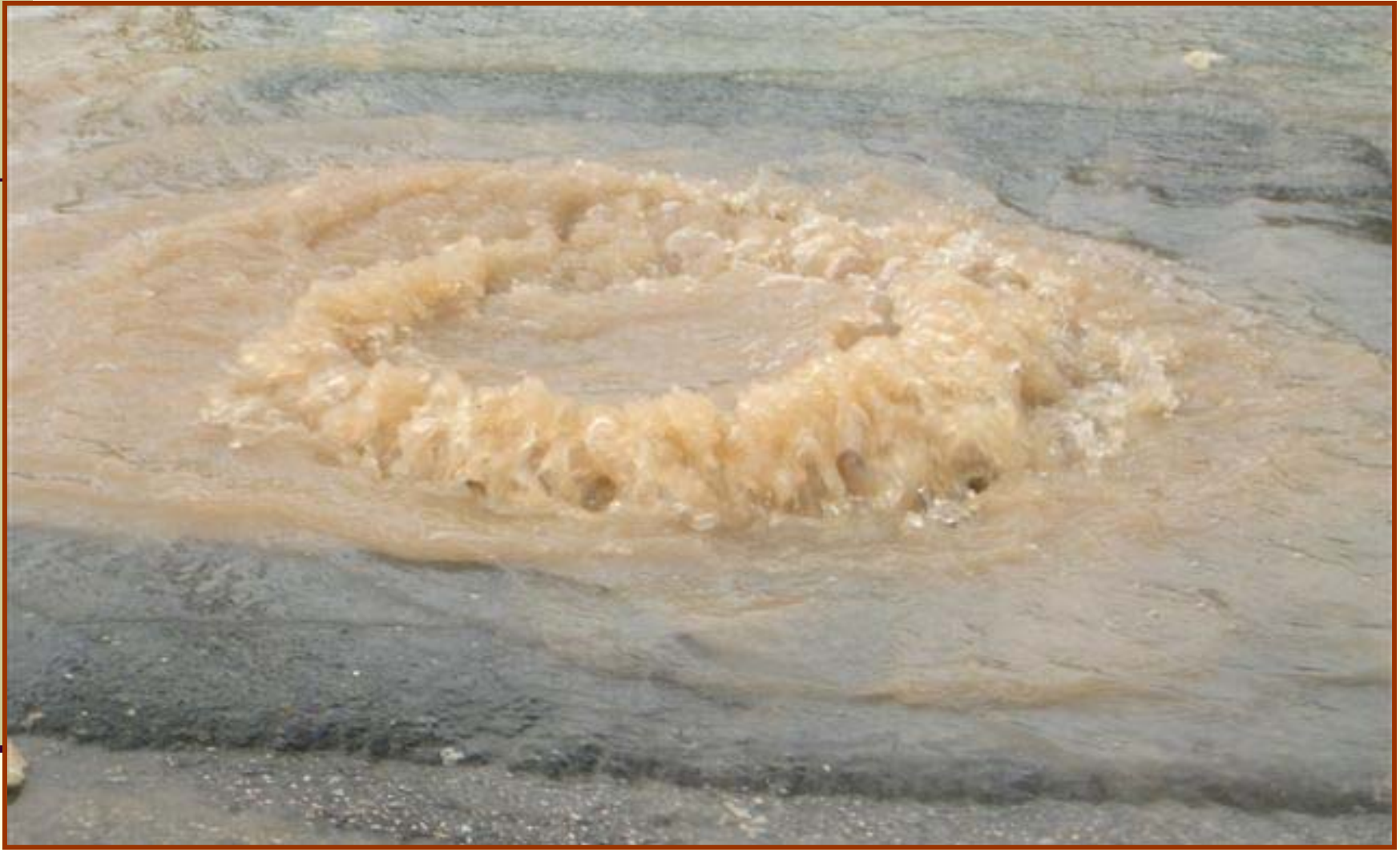
Alcantarilla desbordada en medio de carretera
