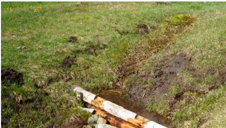
Fot. 112. Jedno z wielu przetamowań zrealizowane w obrębie młak na terenie Gorczańskiego Parku Narodowego (fot. D. Horabik).
