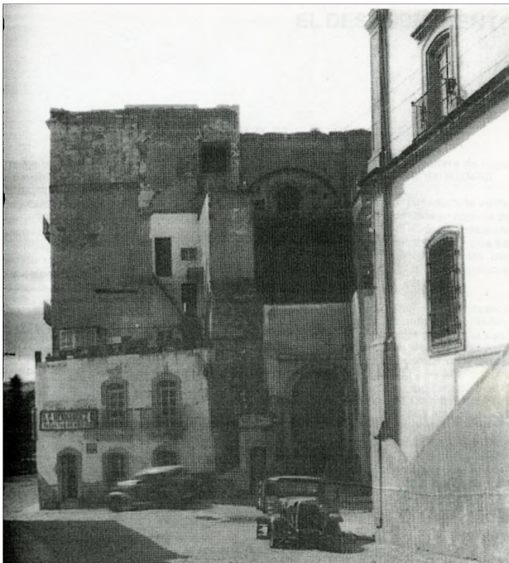
Fachada lateral del antiguo templo de San Agustín antes de la restauración, Ca. 1948
