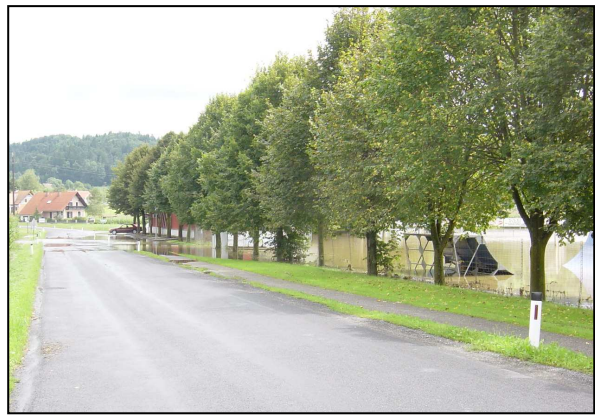
Abbildung 61 zeigt den Sportplatz Großklein, welcher durch ein größeres Hochwasserereignis betroffen war. Quelle: Baubezirksleitung Leibnitz, Hr. Schilling
