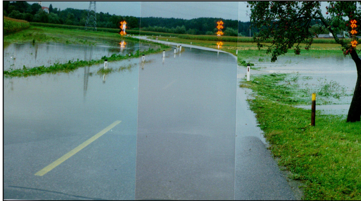
Abbildung 128 zeigt das Hochwasser vom 15.9.1995, wo die Landesstraße in Dobl-Muttendorf betroffen war Quelle: Baubezirksleitung Graz-Umgebung, Hr Stelzl
