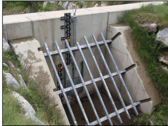
Abbildung 67: Rückhaltebecken Quelle: Eigenaufnahme
