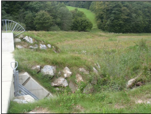
Abbildung 66: Rückhaltebecken Quelle: Eigenaufnahme
