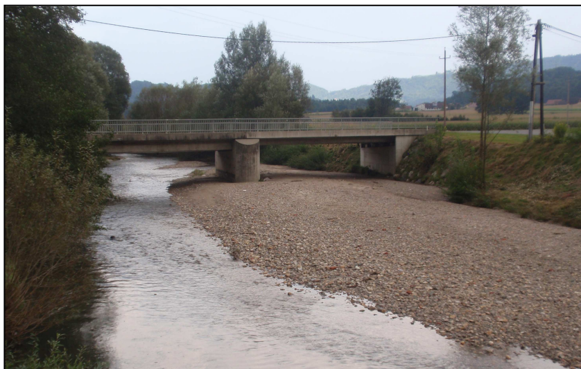
Abbildung 65: Aufweitung der Brücke an der Saggau Quelle: Eigenaufnahme
