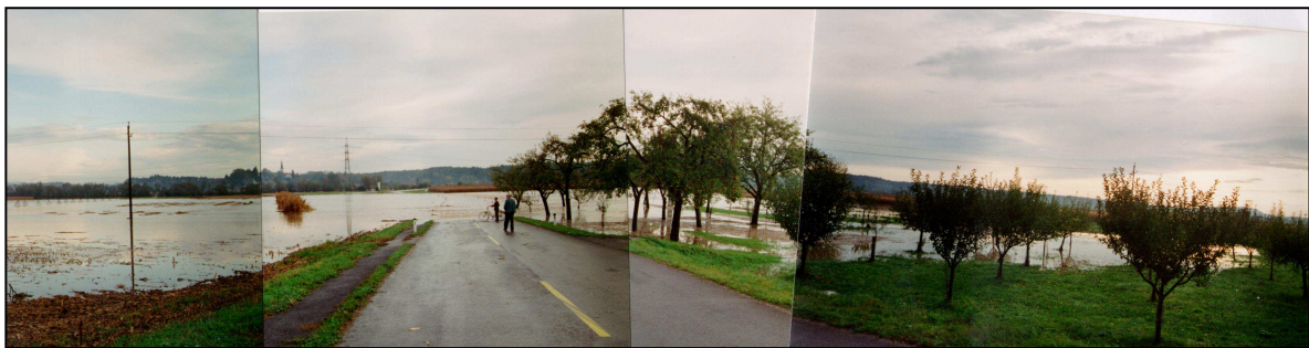
Abbildung 129 zeigt ein weiteres Foto vom Hochwasser vom 15.9.1995, wo die Landesstraße betroffen war Quelle: Baubezirksleitung Graz-Umgebung, Hr Stelzl
