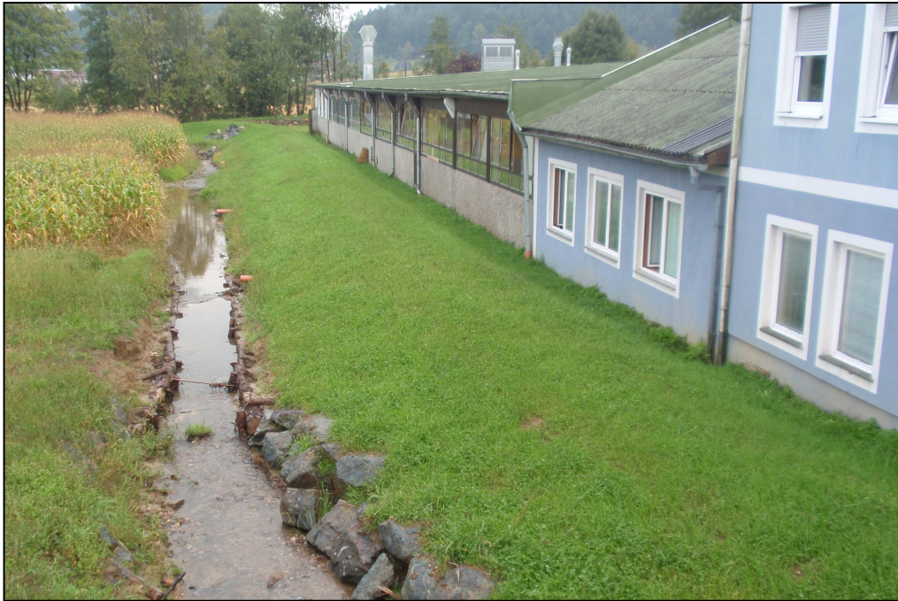
Abbildung 51 zeigt den Damm bei der Tischlerei Semmernegg Quelle: Eigenaufnahme
