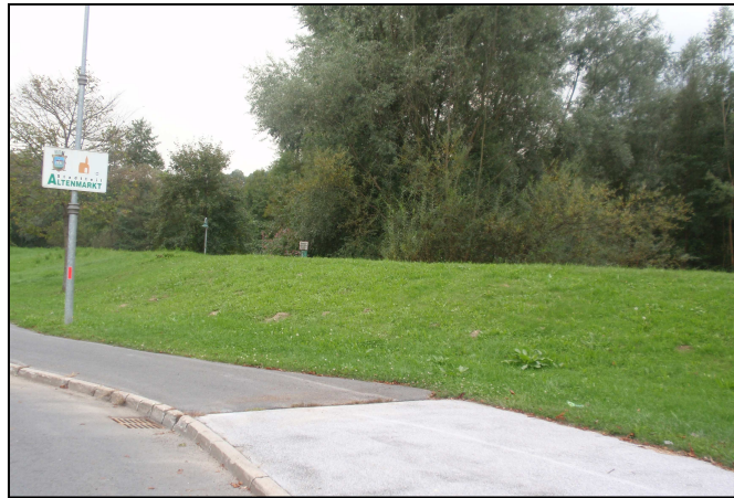
Abbildung 53 zeigt den Hochwasserdamm Ledererbach Quelle: Eigenaufnahme
