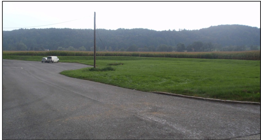
Abbildung 48: Hochwasserdamm bei Firma Assmann Quelle: Eigenaufnahme
