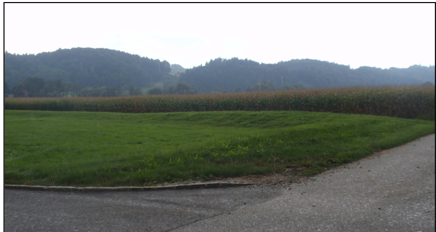
Abbildung 49: Hochwasserdamm bei Firma Assmann Quelle: Eigenaufnahme
