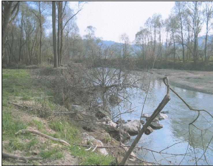
Abbildung 131 zeigt im Hintergrund die Begleitdämme Quelle: Baubezirksleitung Graz-Umgebung, Hr Stelzl
