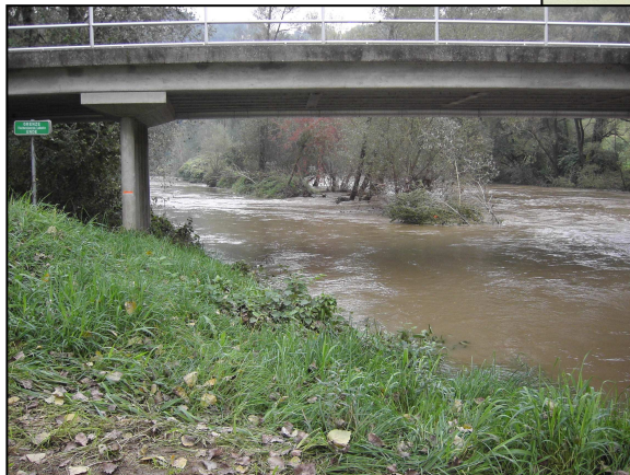
Abbildung 41: Flutmulde Sulmseebrücke Quelle: Baubezirksleitung Leibnitz, Hr. Schilling
