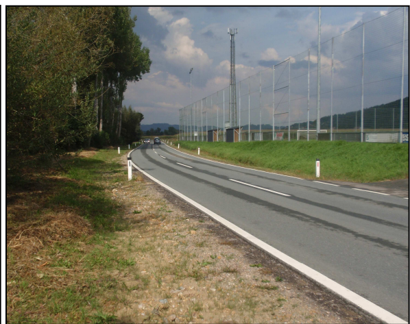
Abbildung 56 zeigt ein Foto der Landesstraße und den höher liegenden Sportplatz Quelle: Eigenaufnahme
