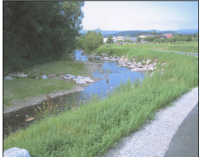
Abbildung 126 zeigt eine Aufweitung der Kainach Quelle: Baubezirksleitung Graz-Umgebung, Hr Stelzl
