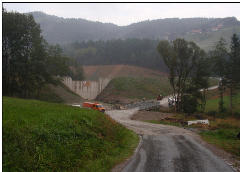
Abbildung 54: Rückhaltebecken in der Gemeinde Wilfresen Quelle: Eigenaufnahme
