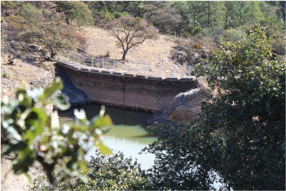
Fig. 11. Presa y cortina de la Presa en el predio Agua Escondida
