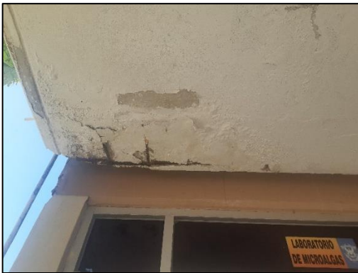
Figuras 3 y 4.- Daño por oxidación en acero de refuerzo y desprendimiento de aplanados por humedad y salinidad en losas.
