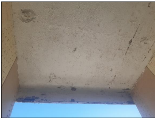
Figuras 5 y 6.- Presencia de humedad y salinidad en áreas de losas.
