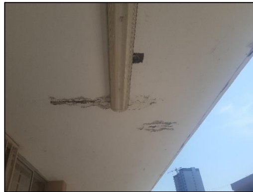
Figuras 3 y 4.- Daño por oxidación en acero de refuerzo y desprendimiento de aplanados por humedad y salinidad en losas.
