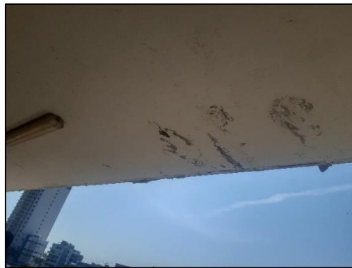
Figuras 5 y 6.- Presencia de humedad y salinidad en áreas de losas.
