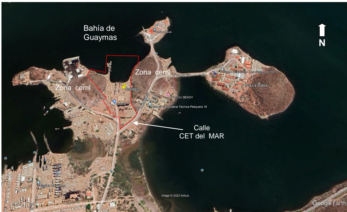
Vista de las colindancias del sitio del proyecto.
