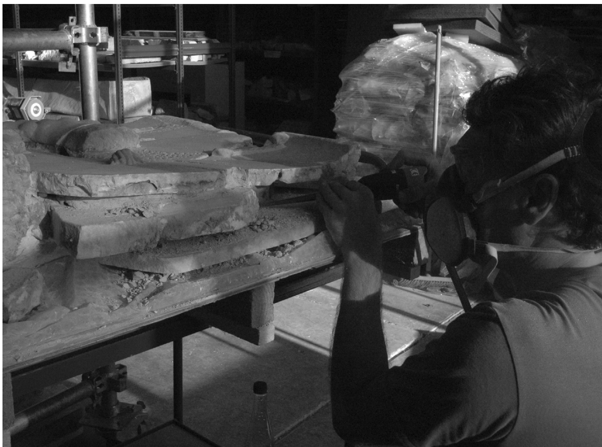
Figure 3 Démontage du ciment liant un relief au ciseau pneumatique. En bas, la plaque de doublage, au milieu, des fragments de marbre dont certains antiques (moulurés) en remploi, en haut le relief sculpté. © E. Desroches
