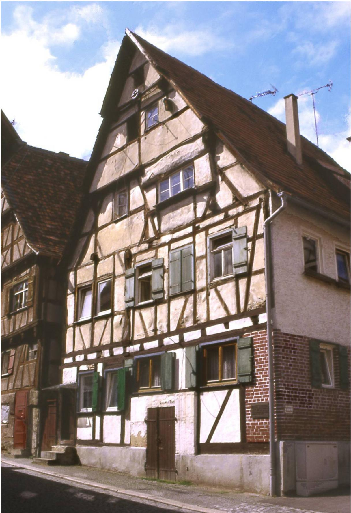
*Sindelfingen, Hintere Gasse 10, errichtet um 1431. Die Fassade zeigt zahlreiche spätere Veränderungen und Reparaturen, die immer wieder in Fachwerk ausgeführt worden sind.*
