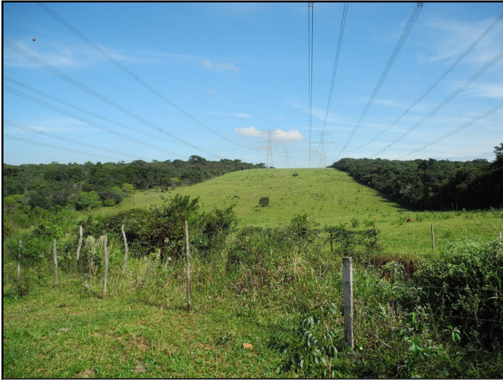
Foto 6.13 - Seccionamento da cobertura vegetal natural provocada pela implantação de linhas de alta tensão, município de Bauru.
