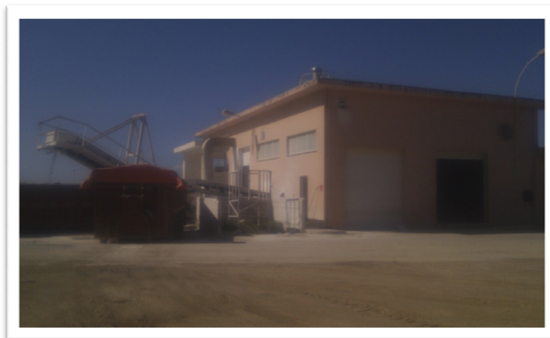
Εικόνα Π.7: Εγκατάσταση αφυδάτωσης ιλύος- Χώρος δειγματοληψίας
