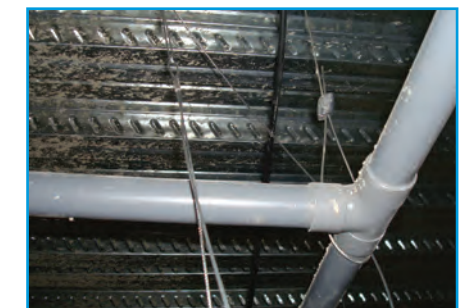
Condensate pipes
