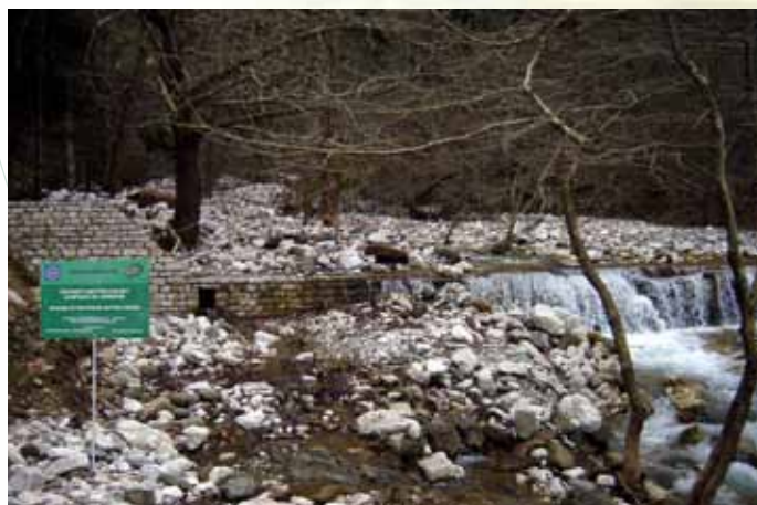
Digue pour éviter l'érosion
