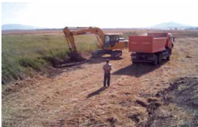
Fermeture du canal de drainage de la lagune de Cantarranas
