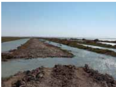
Surbaissement des murs à l'intérieur du marais salant du Consulado
