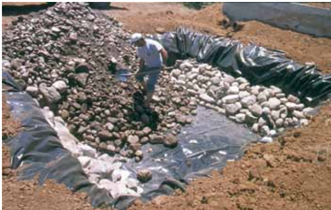
Construction d'une zone humide artificielle
