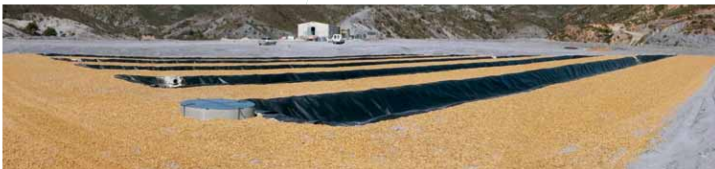
Filtre en construction pour la coopérative porcine Gamur
