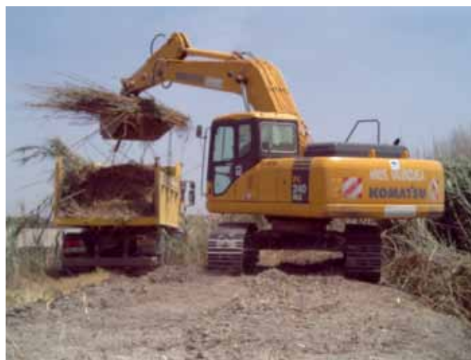
Retrait de la végétation du canal autour de la lagune de Fuente de Piedra
