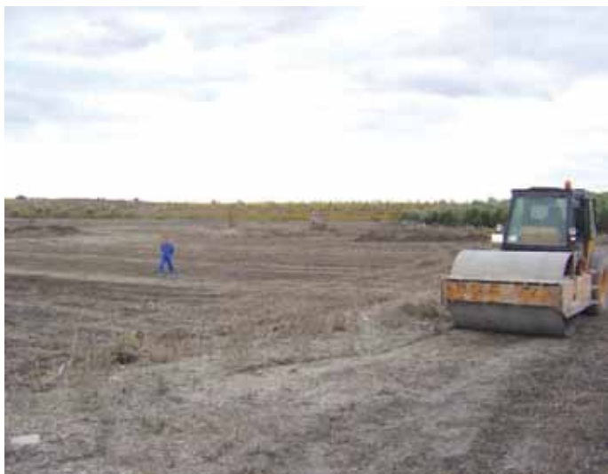
Compactage du sol
