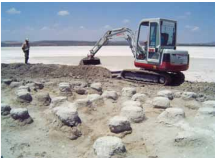
Réhabilitation de digue salicole comme territoire de reproduction des flamands
