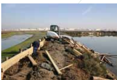
Pose de palplanches et réparation de murs de contention dans "La Covacha"
