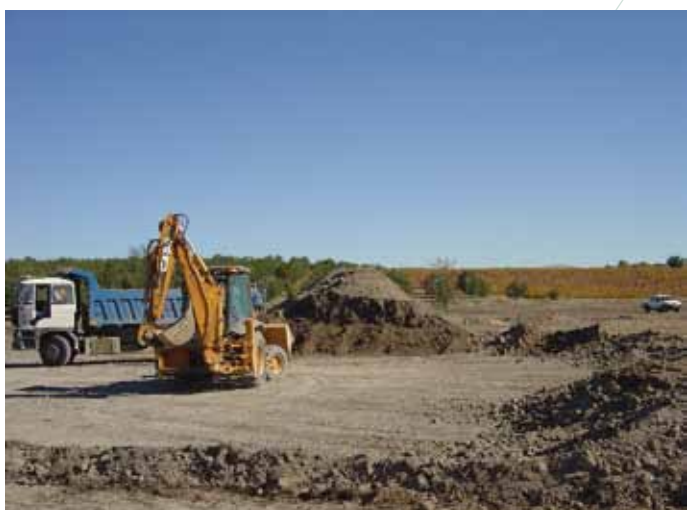
Amoncellement de terre et création de l'îlot dans la lagune de Santiago
