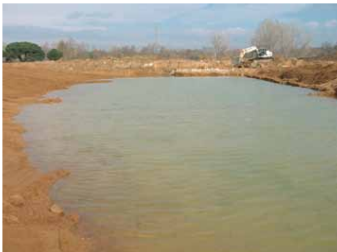
Travaux pour la création d'une zone humide artificielle à Tordena. Projet LIFE « Tordena Aquifère »
