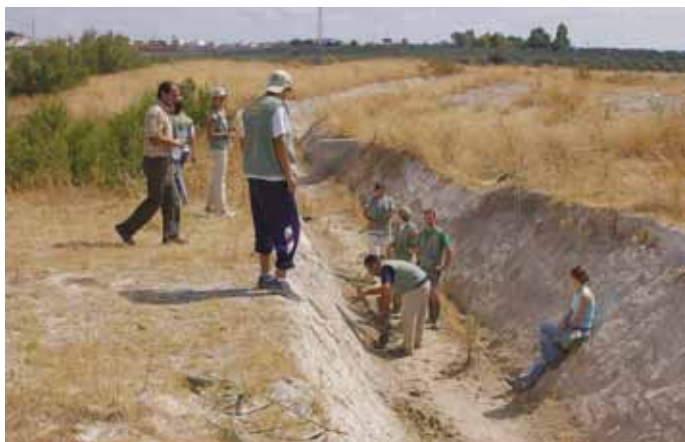
Plantation de roseaux palustres dans un canal pour améliorer la qualité des eaux.
