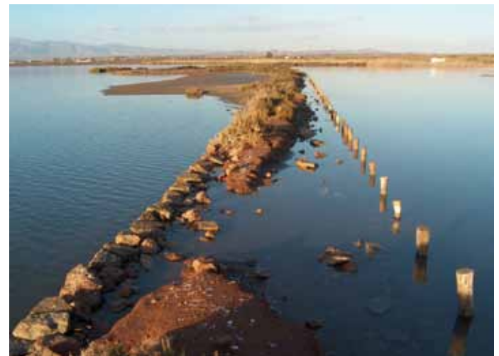
Réhabilitation de l'ancienne digue
