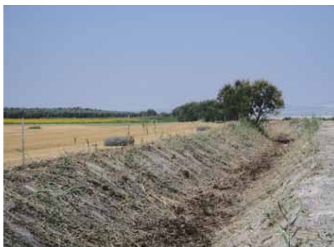
Canal d'irrigation après les travaux de nettoyage des fourrés
