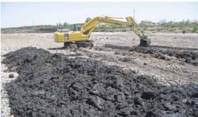
Retrait des boues de Laguneto del Pueblo
