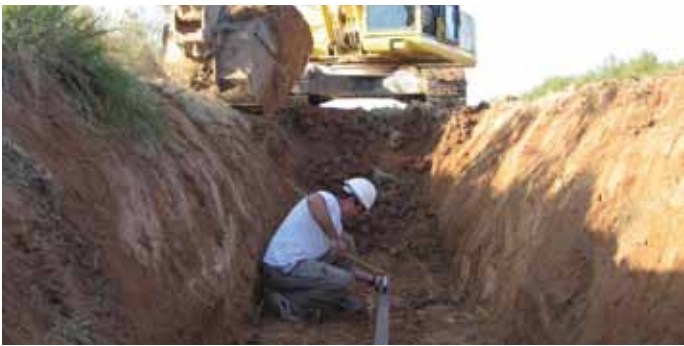
Ouverture de nouveaux canaux pour les apports de la STEP II de Fuente de Piedra
