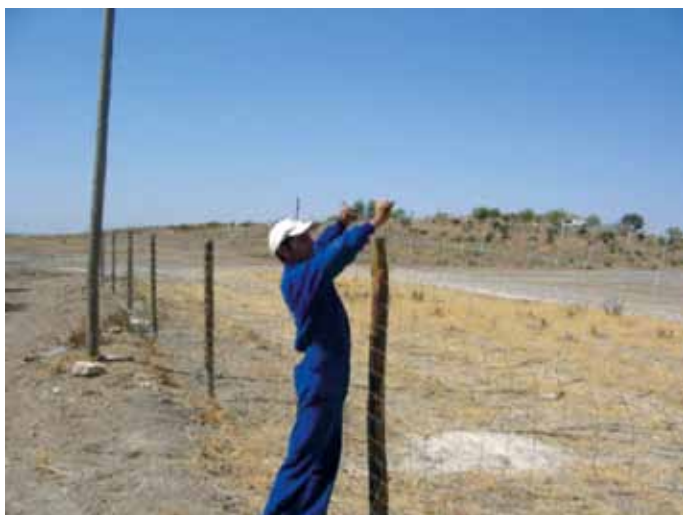
Travaux de mise en place de la nouvelle clôture.
