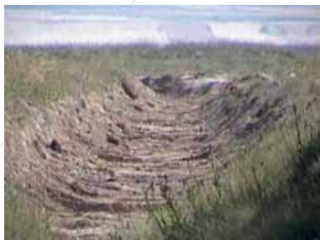
Remplissage de drainage
