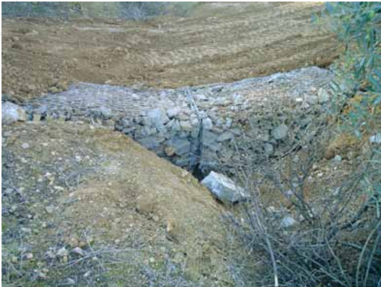
Digue de maçonnerie de gabion pour la correction de la ravine dans la lagune Amarga
