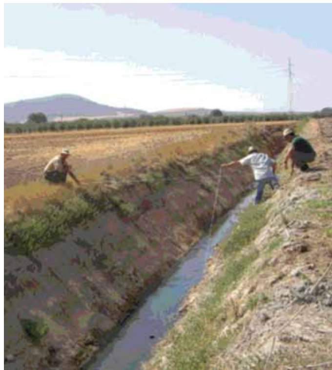
Vérification de la cote du canal de drainage du Laguneto à Fuente de Piedra.
