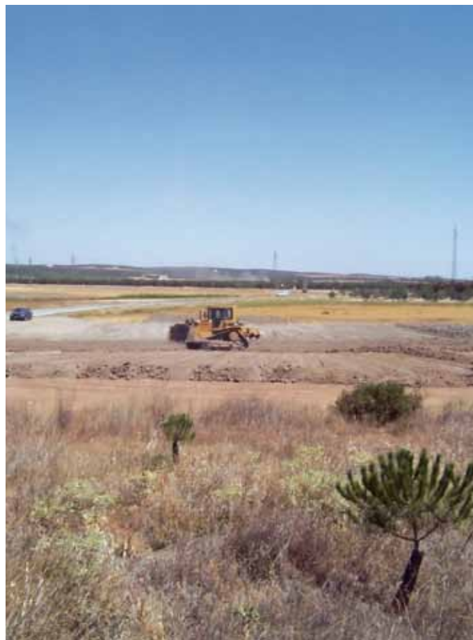
Machine retirant des sédiments de la lagune de Juncares, Fuente de Piedra
