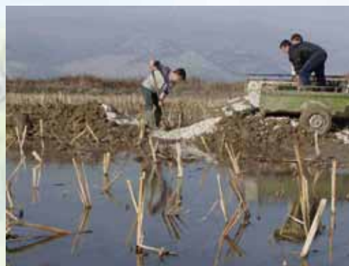
Construction de zones d'amortissement
