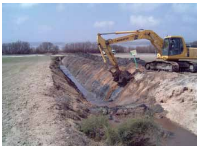
Nettoyage du canal du Laguneto à la Laguna
