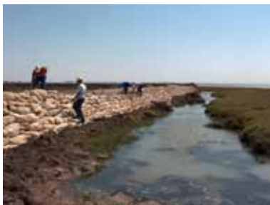
Pose manuelle d'un brise-lames dans le marais salant du Consulado
