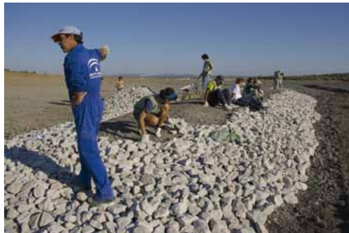
Protection d'une île contre l'érosion à l'aide de pierres dans le Laguneto
