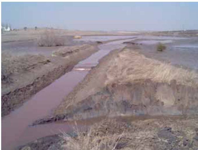
Drainage de Laguneto del Pueblo
