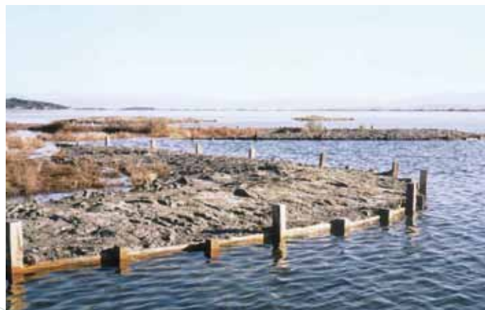
Palissade visant à mettre fin à l'érosion de l'îlot « Imiselinos » du lac Tsoukalio
