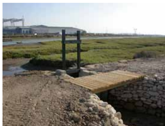
Vanne restaurée dans le marais salant du Consulado
