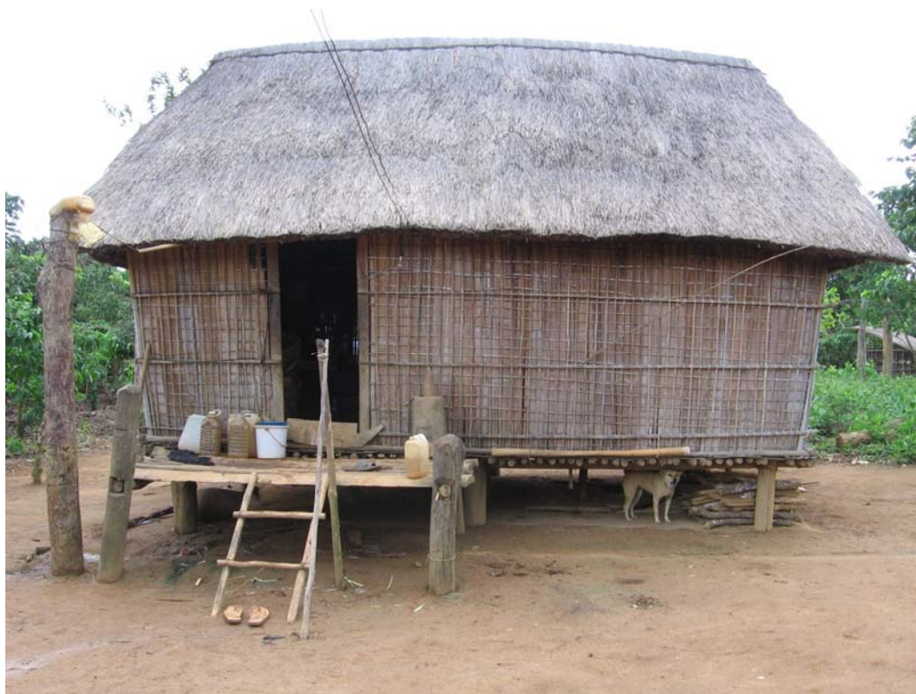
Hình 8. Ngôi nhà truyền thống của người Bana (tại Sơ Pai) được làm gần như hoàn toàn bằng vật liệu từ rừng (Ảnh WWF-2008)
