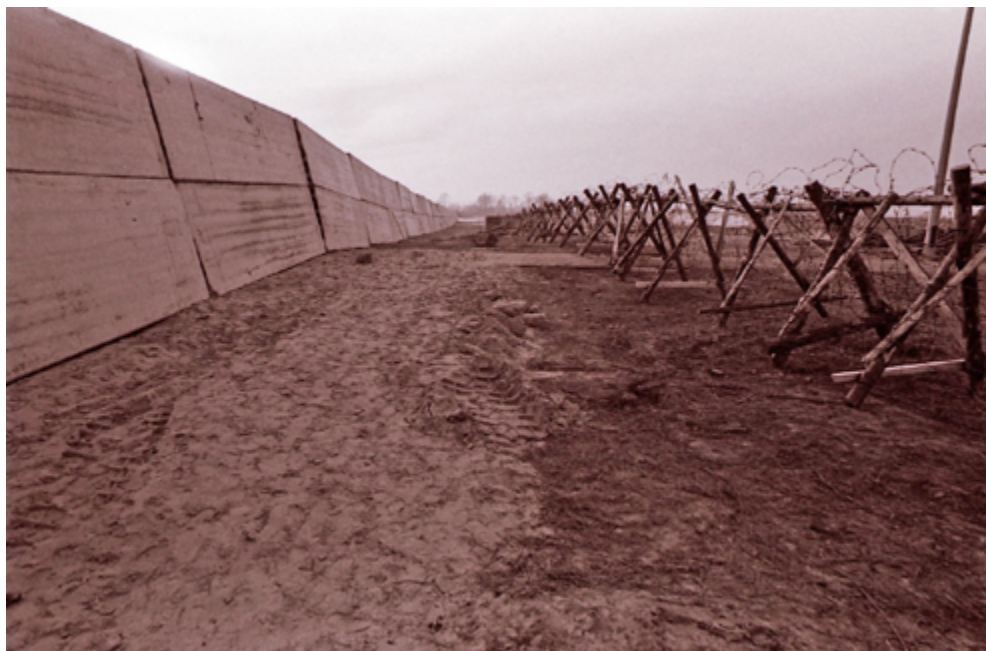
Dzelonģdrāšu un betona bloku aizsargsienas pie TV torņa Zaķusalā. Ilmāra Gradovska foto.
