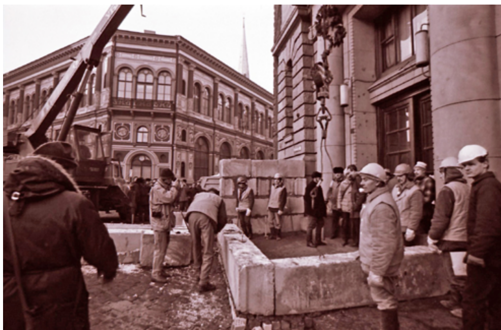
Dzelzsbetona pamatu bloku barikādes būvniecībā pirms ieejas Radio mājā Doma laukumā. Ilgvara Gradovska foto.
