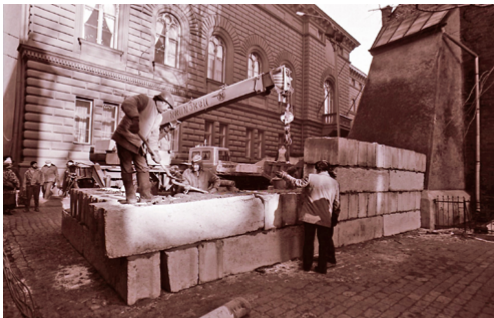
Barikādes celtniecība Klostera ielā pie Augstākās padomes ēkas. Ilgvara Gradovska foto.
