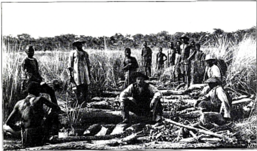
Brückenbau am Maschonge
