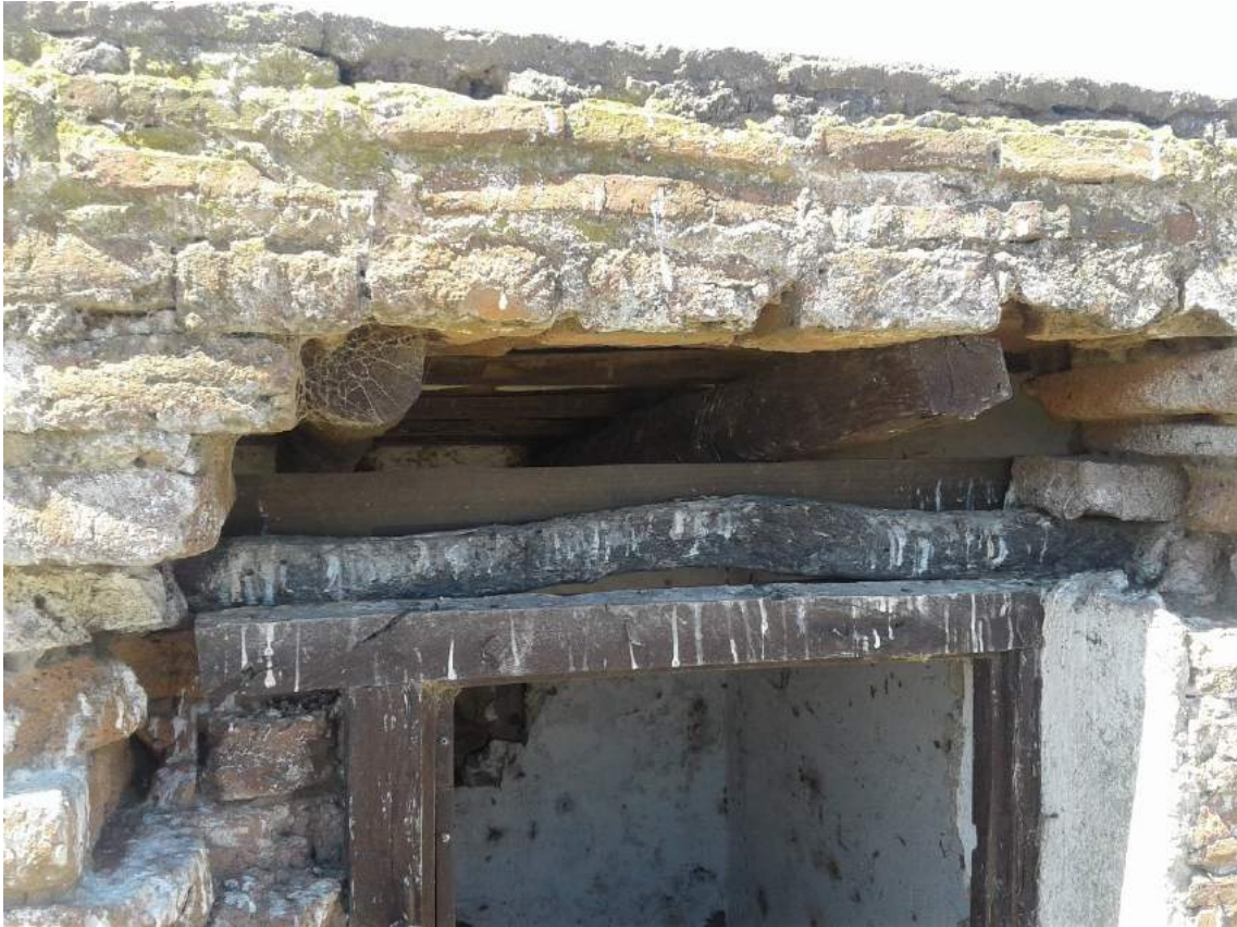
Detalle de dintel. Acceso a la azotea.
