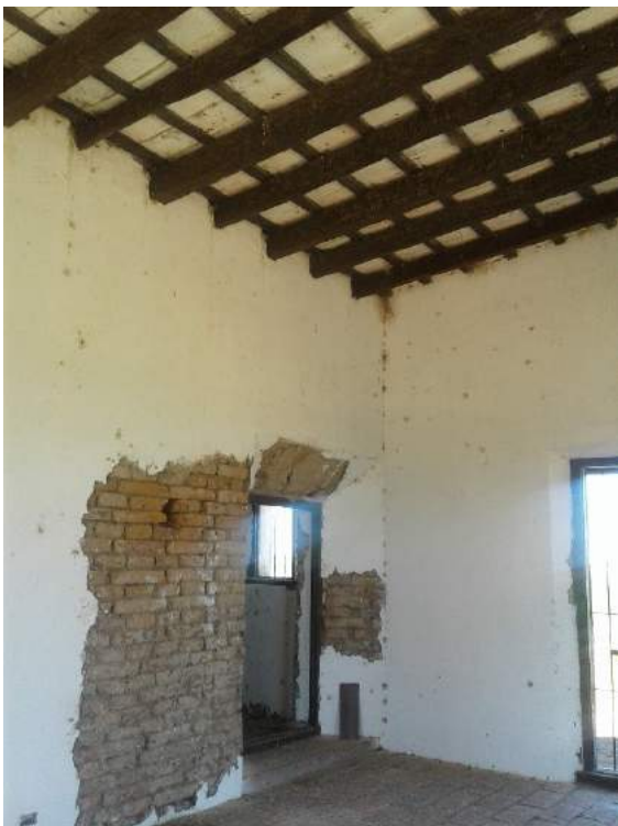
Detalle de dintel. Acceso a la azotea.
