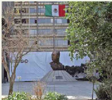
Así lucía ayer el edificio B2 en que se registró el estallido que ocasionó la muerte de 37 personas.
