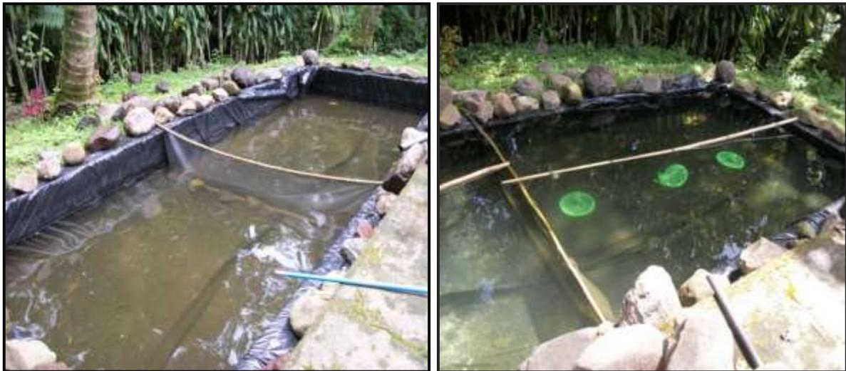
**Figura No. 7.** Estanque de concreto forrado con nylon UV
