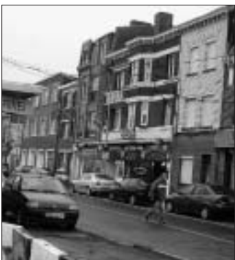
La pose de l'enrobé final commencera le 27 mai.
