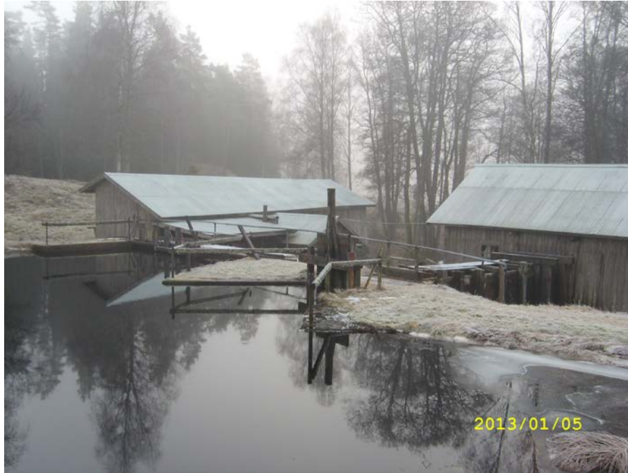
Figur 6 Dammluckan med tilloppsrännan och turbinsumpen. I bakgrunden t.v. sågen och t.h. maskinhuset.
