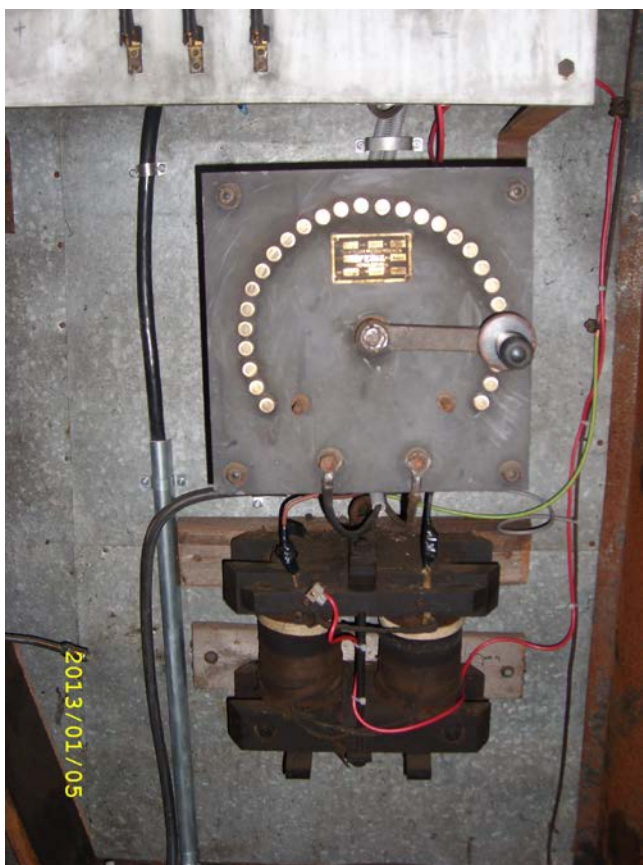
Figur 11 Shuntmotståndet och spänningsdelaren, monterade under mätartavlan.
