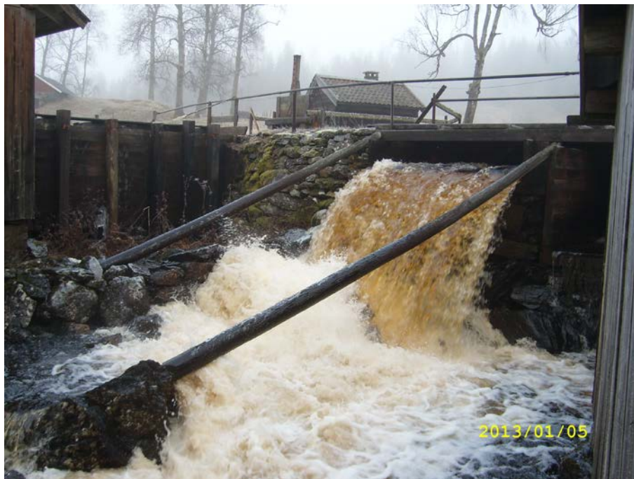
Figur 7 Dammbanken med skibordet, placerat mellan kraftstationen och sågverket. Till vänster syns tilloppsrännan till turbinsumpen.
