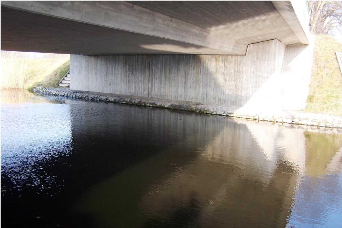
Abb. 6: integrierte Otterschutzmaßnahme an der Brücke am Peenesüdkanal bei Sarnow (M-V)
