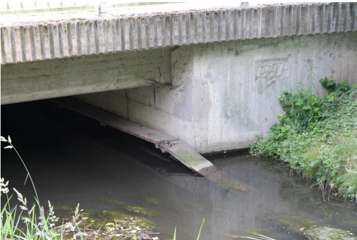
Abb. 9: Nachrüstung einer Otterschutzmaßnahme an der Linde in Neubrandenburg (M-V)
