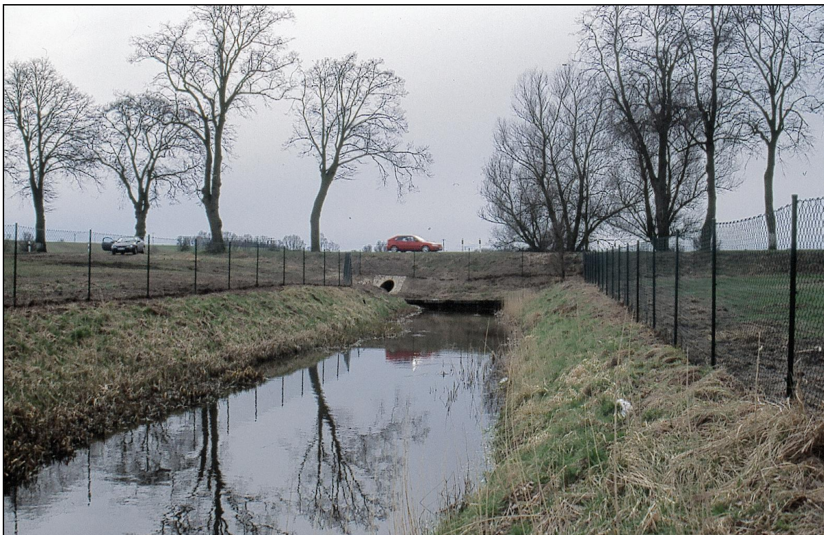
Abb. 11: Trockenröhre mit Leitzaun am Melzenbach bei Burg Stargard (M-V)
