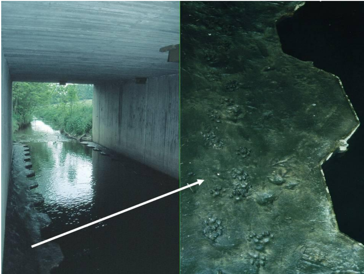
Abb. 4/5: Eine Otterschutzmaßnahme mit Hilfe von Spuntwänden an der Linde zwischen Leppin und Rosenhagen (M-V)
