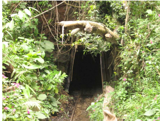
Figura 15. Bocamina Mina carolina 2.
