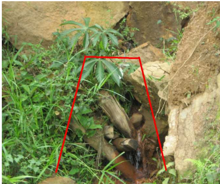
Figura 12. Bocamina derrumbada.
