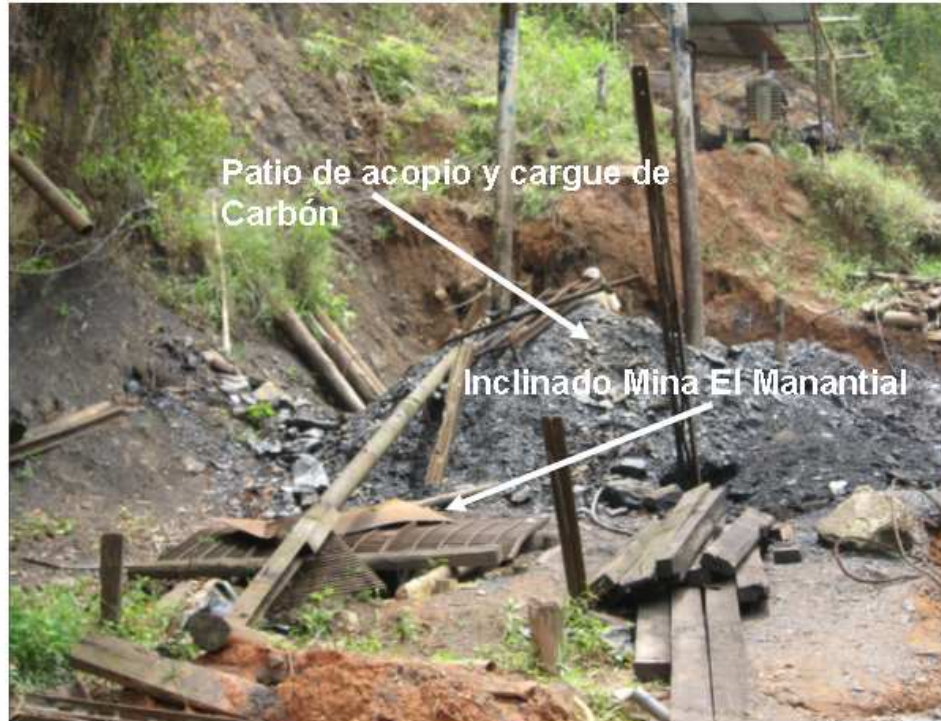
Figura 7. Patio de acopio y cargue de carbón de la Mina El Manantial.
