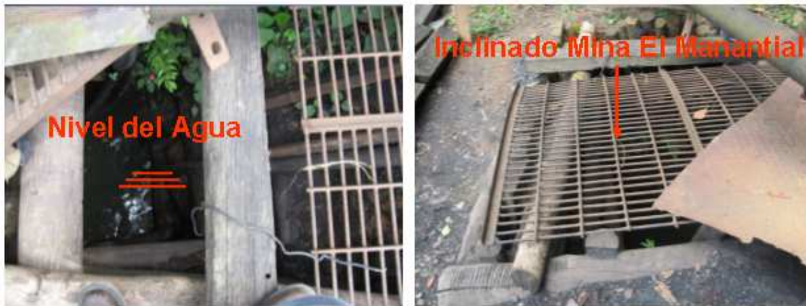
Figura 6. Labores Inundadas del Inclinado de la Mina El Manantial.
