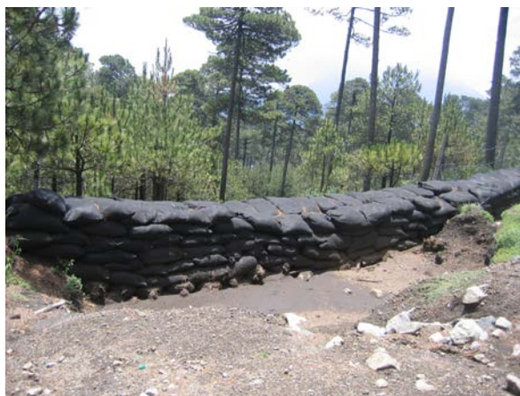
Obras de conservación de suelo y agua, en este caso, presas de costales de arena.
