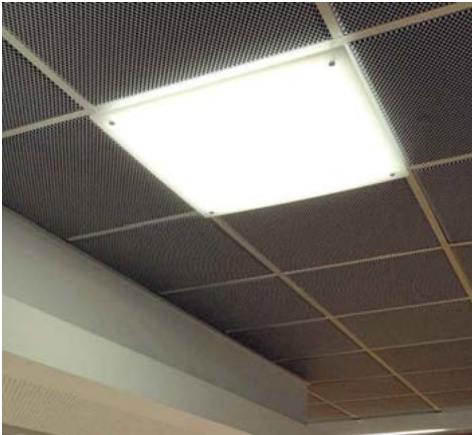
Réglage, par simple vissage, de la hauteur du diffuseur jusqu'à 2 cm.
