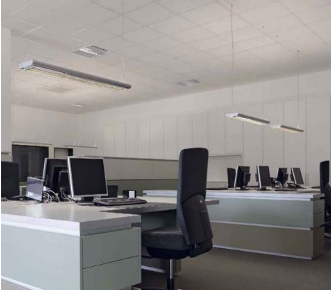
Les suspensions Long Grill et Work light sont équipées de grilles basse luminance adaptées au travail sur écran (norme DIN 5035-7). Elles apportent un éclairage optimal au poste de travail.
