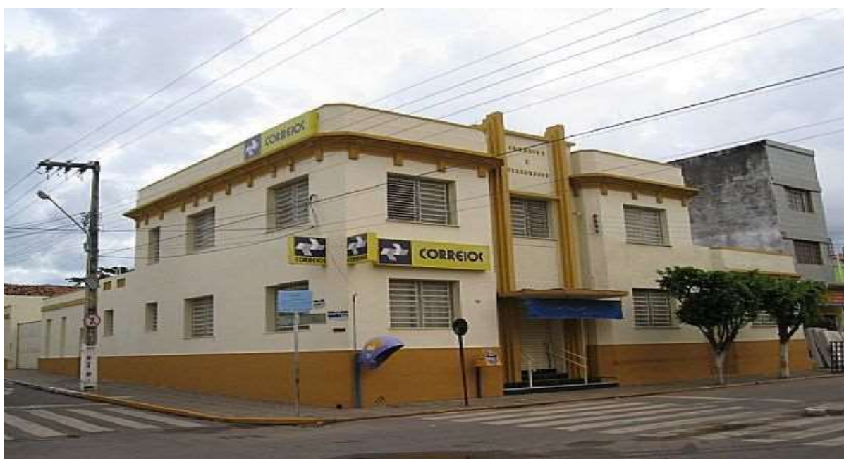
Correios e Telégrafos. Foto: Acervo do ICC
