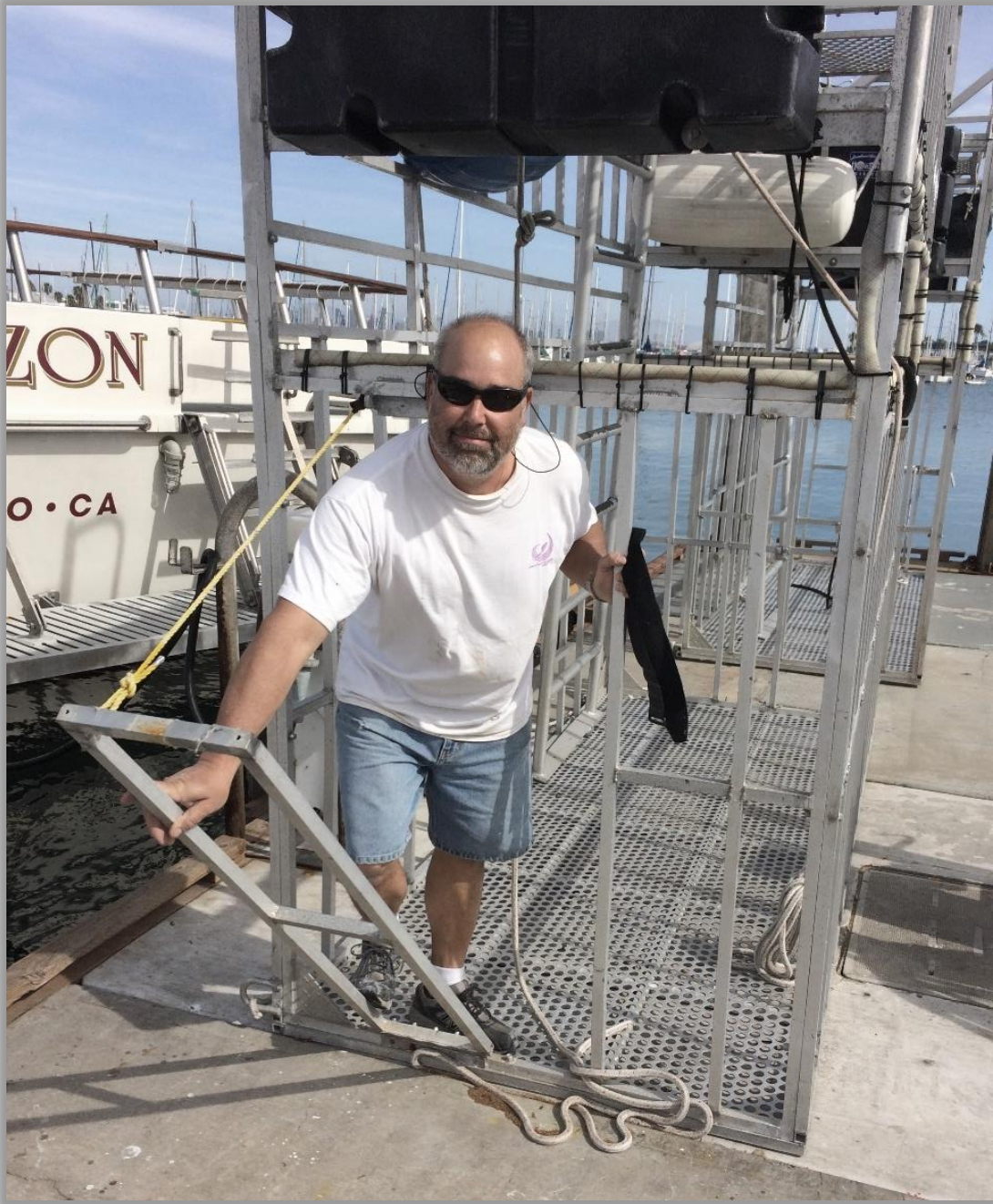
Figura 6. Salida de emergencia.
