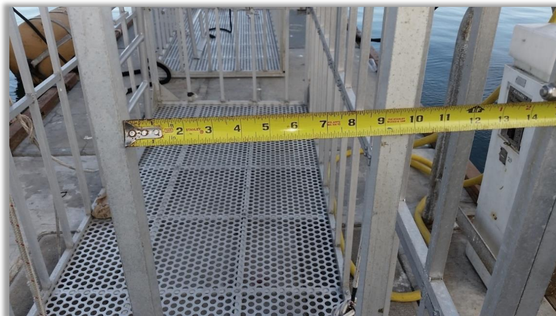
Figura 7. Barrotes laterales y piso de las jaulas.
