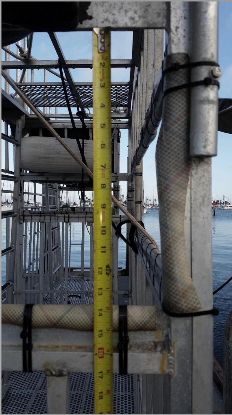
Figura 8. Abertura lateral para cámaras.
