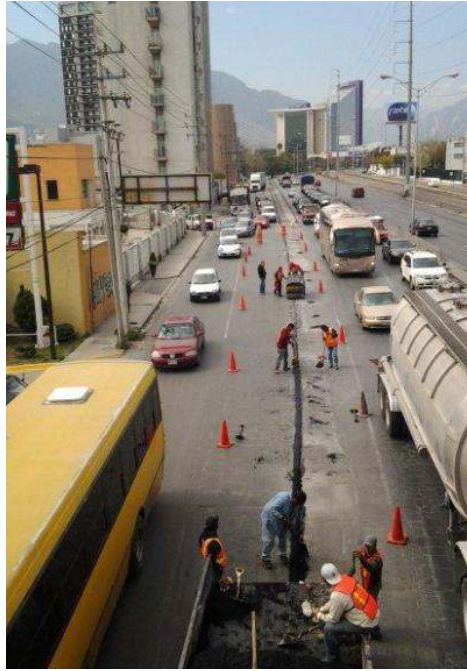
ILUSTRACIÓN 3 COLOCACIÓN DE FIBRA
