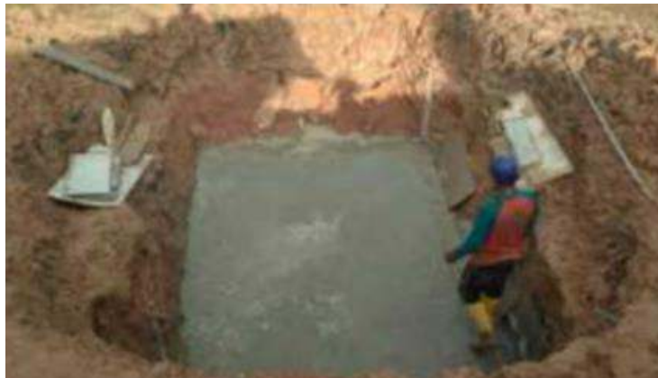
ILUSTRACIÓN 11 COLOCACIÓN DEL BEACH MANHOLE
