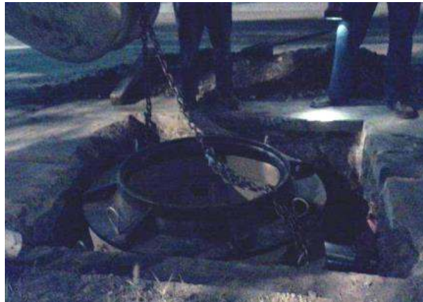
ILUSTRACIÓN 8 INSTALACIÓN DE MANHOLE
