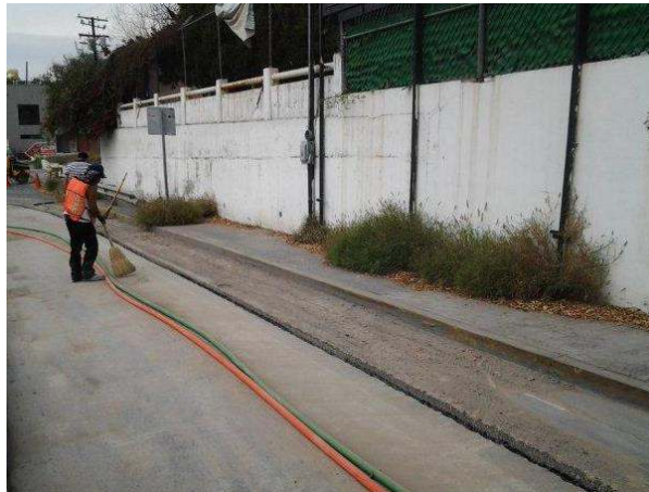
ILUSTRACIÓN 2 COLOCACIÓN DE TUBO
