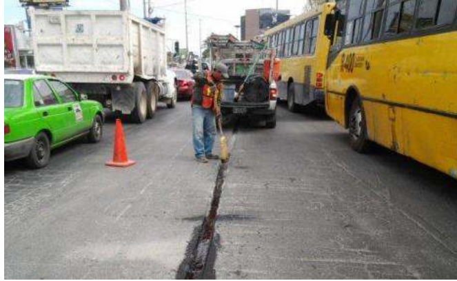
ILUSTRACIÓN 7 CANALIZACIÓN TRADICIONAL
