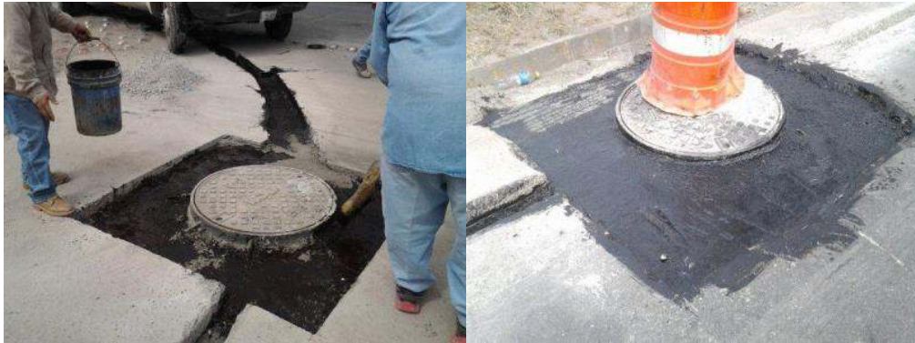
ILUSTRACIÓN 9 INSTALACIÓN DE MANHOLE
