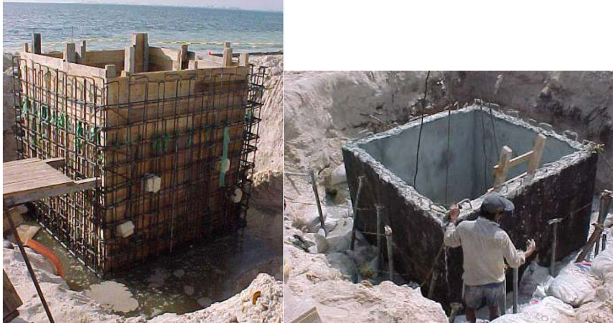
ILUSTRACIÓN 13 CONSTRUCCIÓN BEACH MANHOLE
