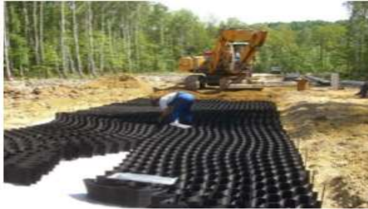
Figura 14. Técnica de construcción de terracerías con gravas confinadas.
