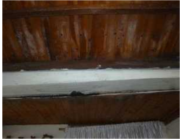
Pared y Techo con Humedad
