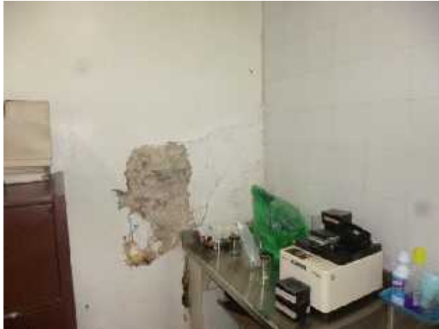
Pared y Techo con Humedad
