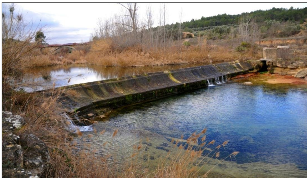
Fotografía 11. Azud y conducción de agua en el cauce del río Tastavins poco antes de la desembocadura
