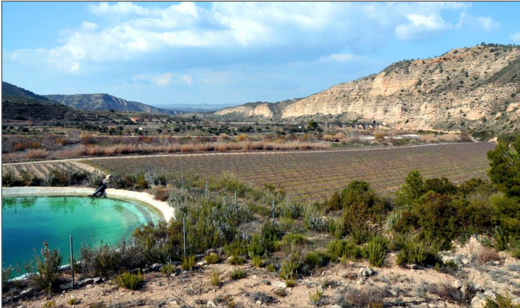
Fotografía 24. Balsa de reducida superficie, profunda, impermeabilizada y de bordes abruptos y estériles. Nuevas plantaciones de viñedo con riego por goteo y recolección mecanizada
