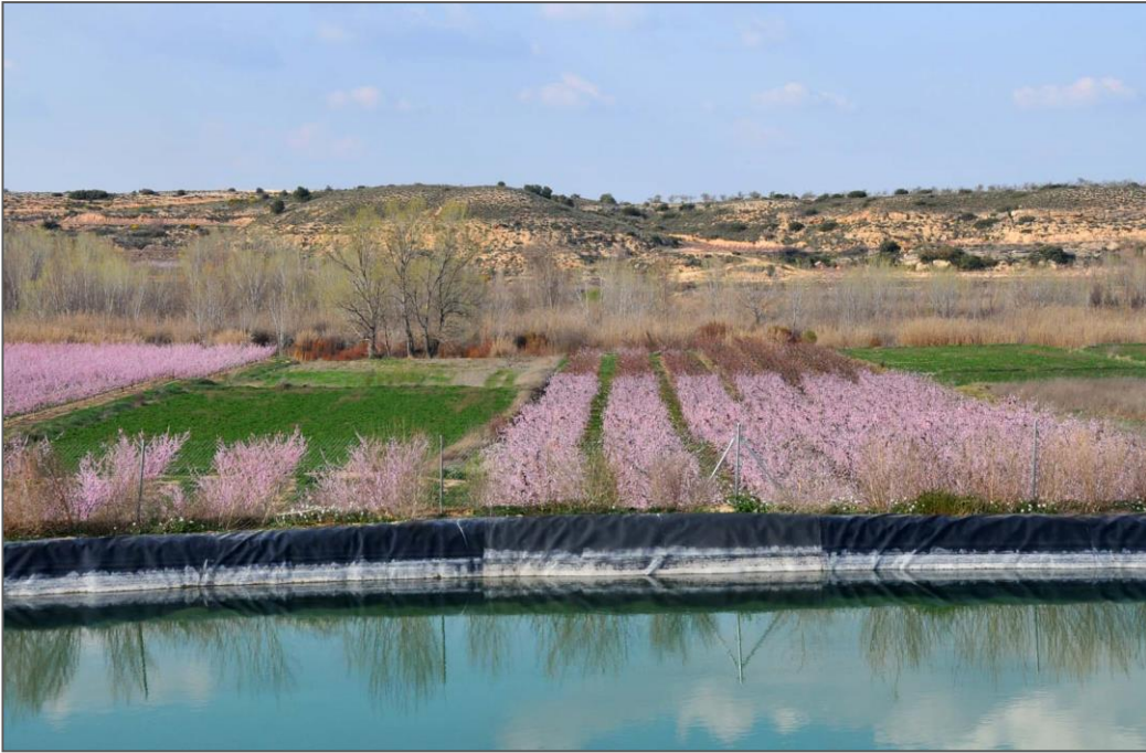
Fotografía 22. Balsa impermeabilizada y vallada para evitar accidentes y muerte de la fauna
