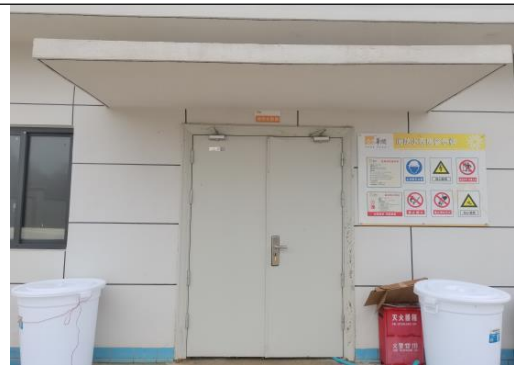
升压站内危废间
