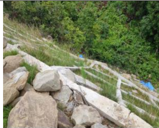
风电机组区填方边坡框格护坡
