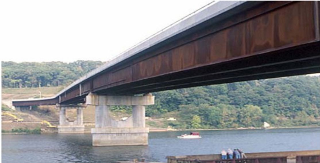
Figura 2.2 - Puente de Ford City, Pennsylvania. Fuente: HPS Designers' Guide (2002).
