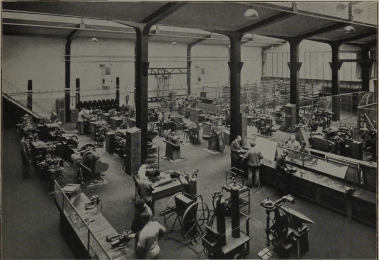
Abbildung 14. Blick in die Halle der mechanischen Werkstatt.
