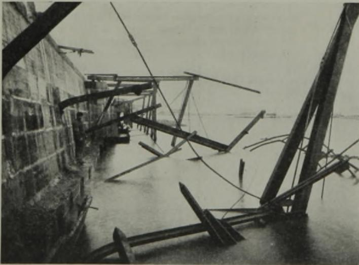
Abb. 16. Baugerüst hinter der Westmole nach einer Sturmflut.
