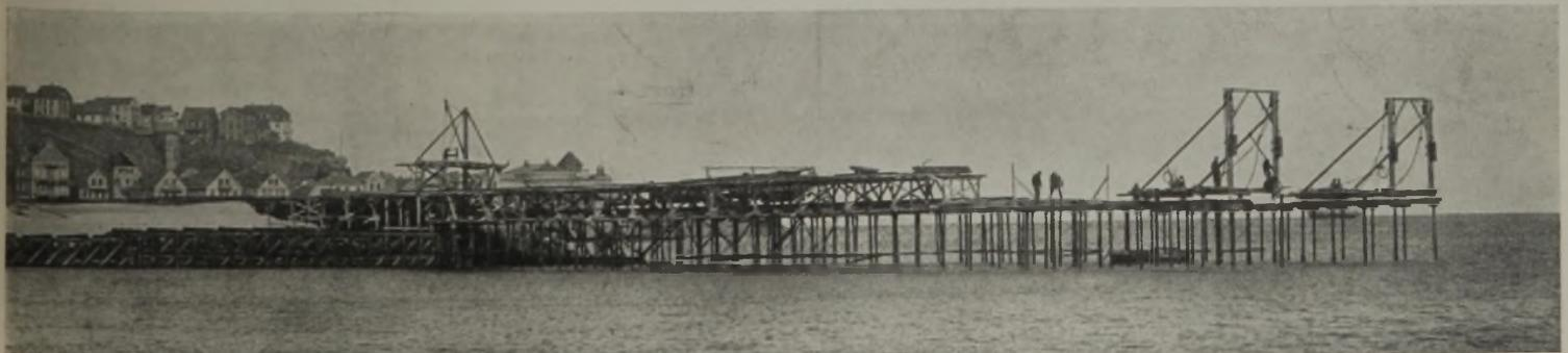
Abb. 26. Trichtergerüst für die Ostmole.
