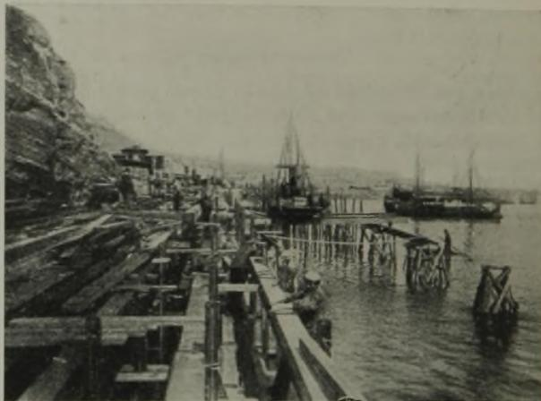
Abb. 3. Bau des Lagergerüsts.
