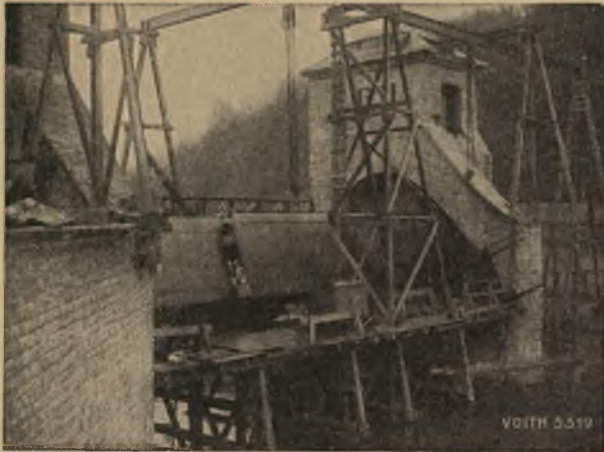
Montage eines Segmentwehres von 20 m li. W.
