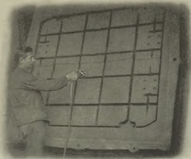
Abb. 1558. Abblasen einer Form mittels Preßluft-Abbläser.
