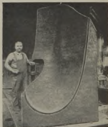
Abb. 774. Zum Trocknen fertiger Gehäusekerne.
