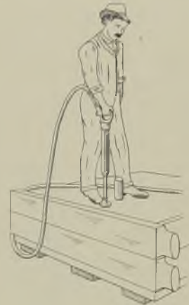
Abb. 11. Preßluftstampfer mit Handgriff.
