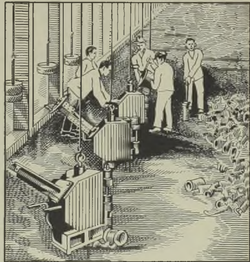
Abb. 1660. Ausziehen des Kerns mittels Hebezeug.
