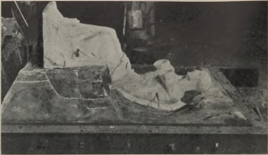
Abb. 712. Unterteil mit eingebettetem Gipsmodell.
