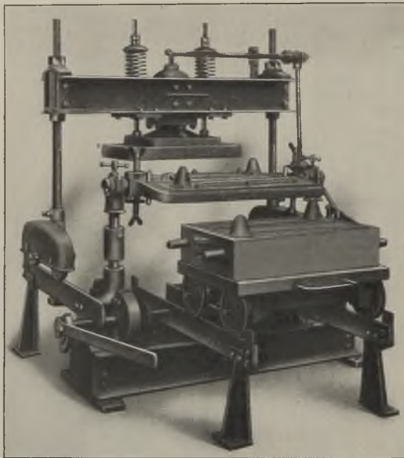
Abb. 1282. Wendepattenformmaschine mit Druckwasserantrieb und oberer Pressung.
