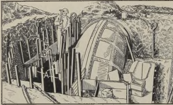
Abb. 793. Halb fertige Form eines Turbinen-Spiralgehäuses.
