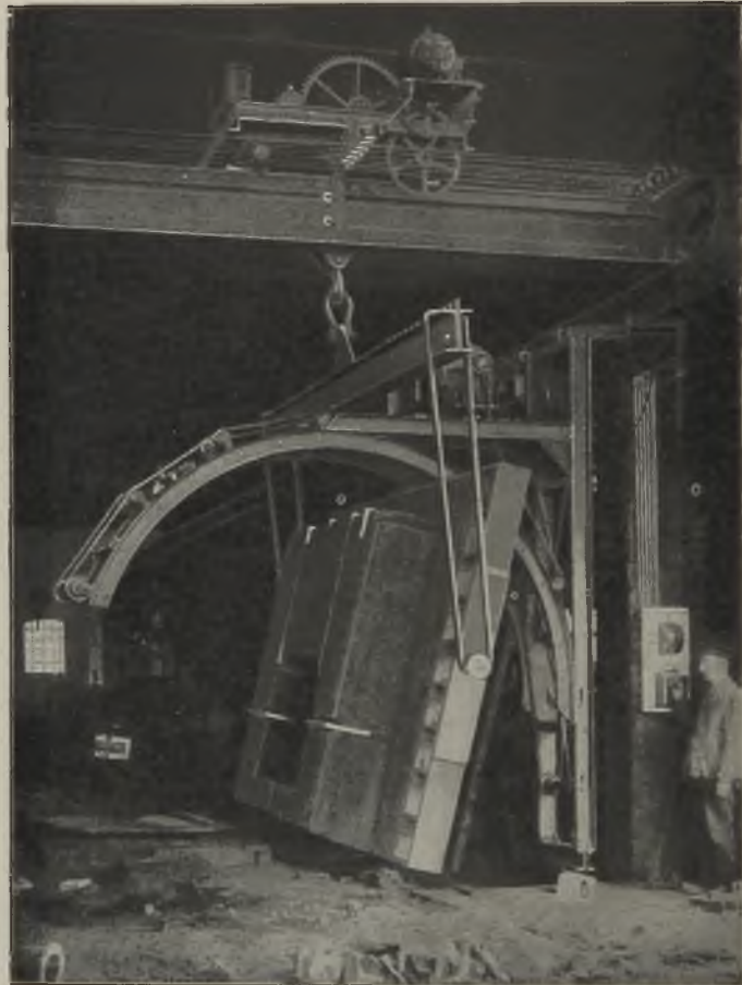
Abb. 724. Ortsfeste Wendevorrichtung mit Laufkran.
