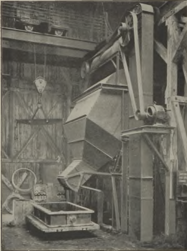
Abb. 1544. Sandbunkeranlage und Sandzuteiler für größere Rüttelmaschinen.
