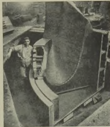
Abb. 771. Teile einer Schaufel-Kernbüchse.
