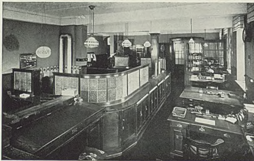
Innenansicht der Kassenräume
