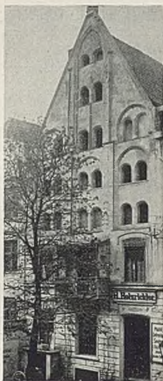
Mittelalterlicher Speicher (Backsteinbau) Brückstr. 30, Putz aus späterer Zeit
