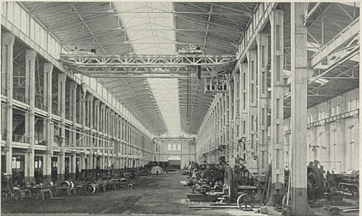
Neue Maschinen-Montagehalle von F. Schichau, Elbing (Teilansicht)
