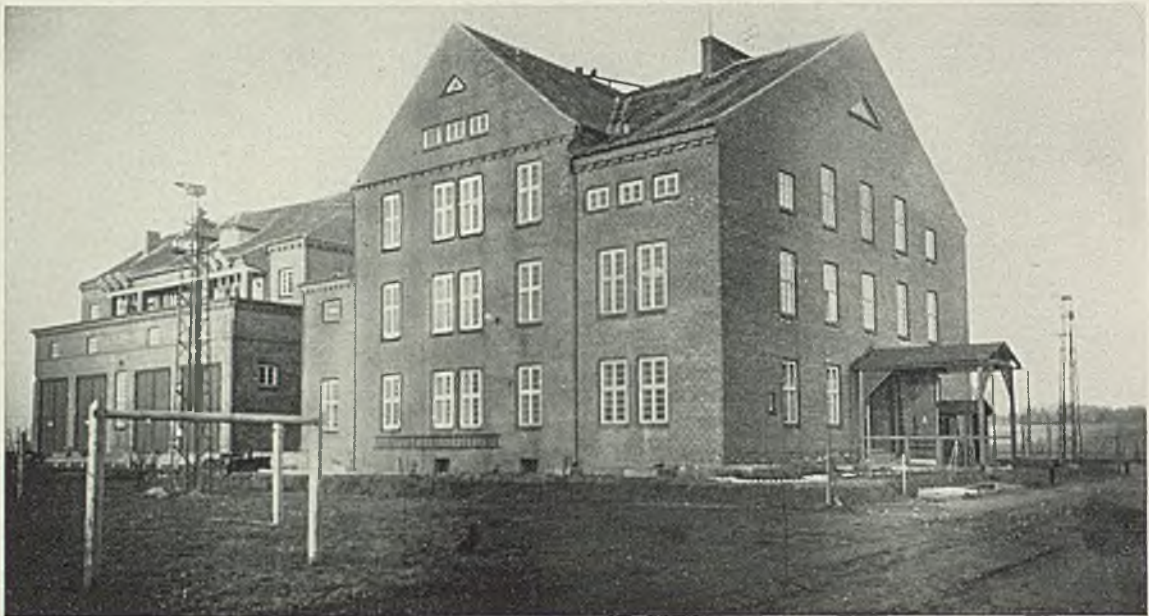
Umspannwerk Elbing des Ostpreußenwerks 60 000/15 000/6 000 Volt
