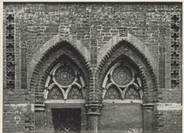
Nordportal der St. Nicolaikirche Phot. Georg Müller AG. Osthaus-Archiv, München
