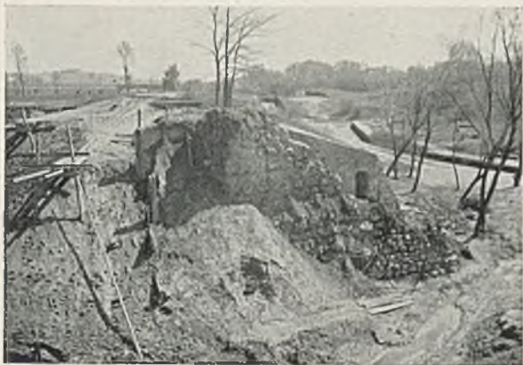
Wiederherstellung des Staudammes zwischen Roebener Wiesen und Pulvergrund, welcher bei der Hochwasserkatastrophe im August 1924 zum Teil fortgerissen wurde
