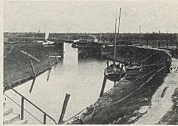
Kraffohlkanal mit Schleuse
