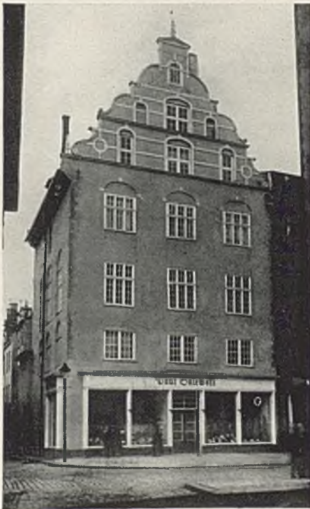
Renaissance-Haus, 1598, Schmiedestr. 10, in der Wiederherstellung durch Prof. Fr. Fischer in Hannover Phot. L. Basilius
