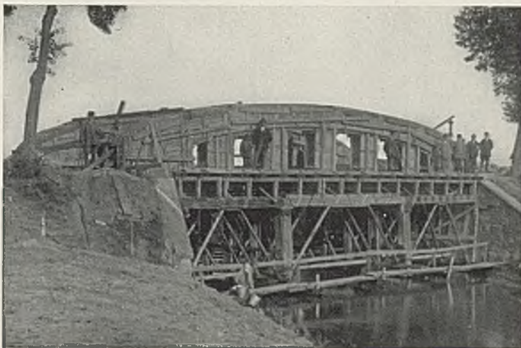
Wiederherstellung des Staudammes zwischen Roebener Wiesen und Pulvergrund, welcher bei der Hochwasserkatastrophe im August 1924 zum Teil fortgerissen wurde
