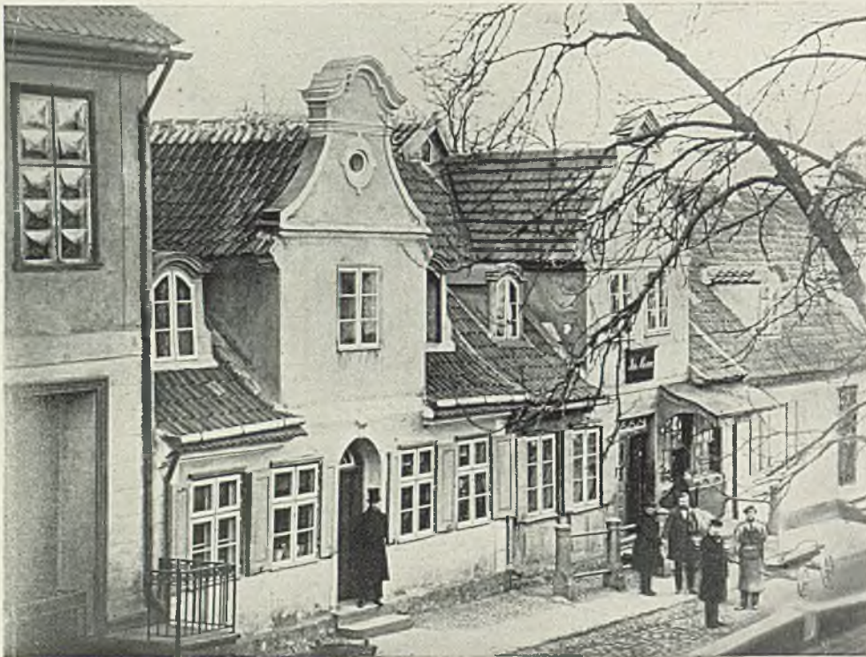
Vorstadtlhäuser in der Schichaustraße. Früherer Zustand
