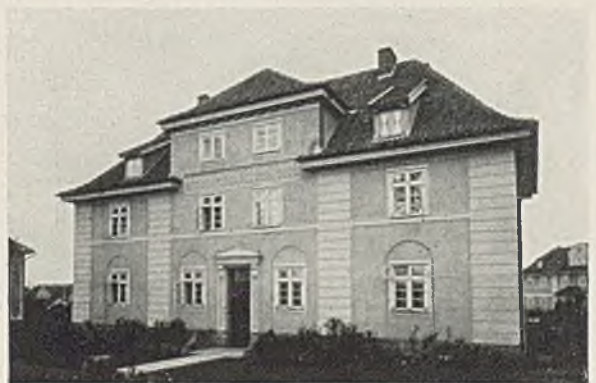
Ein Sechsfamilienwohnhaus der Elbinger Heimstätten an der Königsberger Straße
