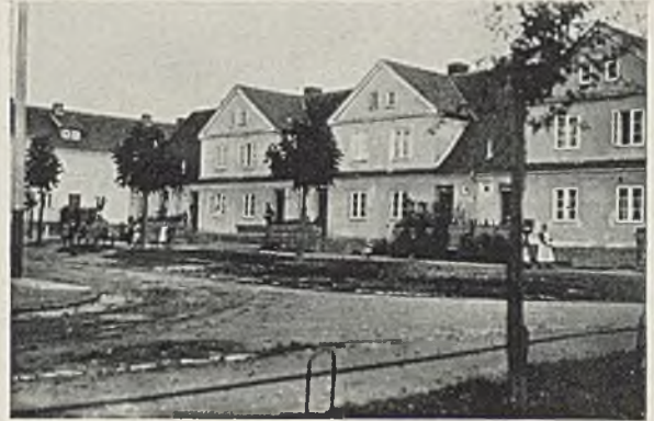
Platzanlage in den Elbinger Heimstätten
