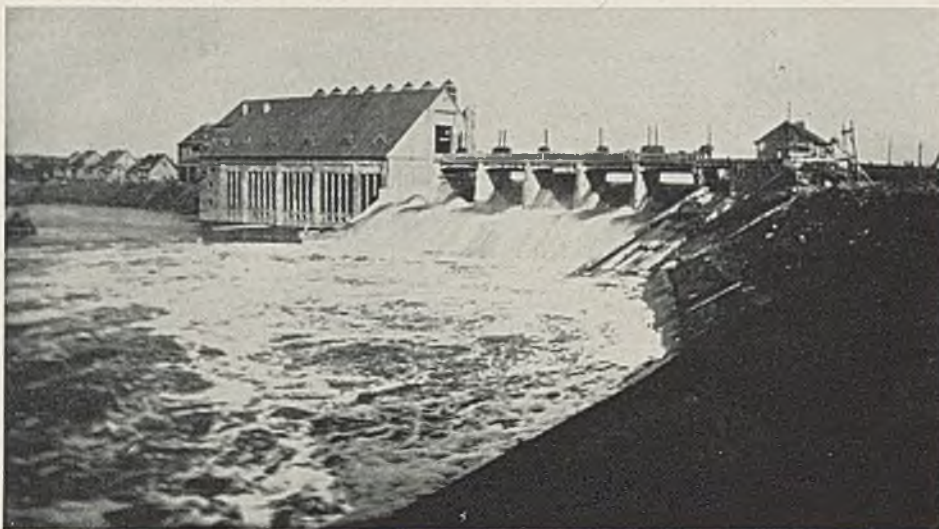
Wasserwerke der Ostpreußenwerk Akt. Ges., Kraftwerk Friedland
