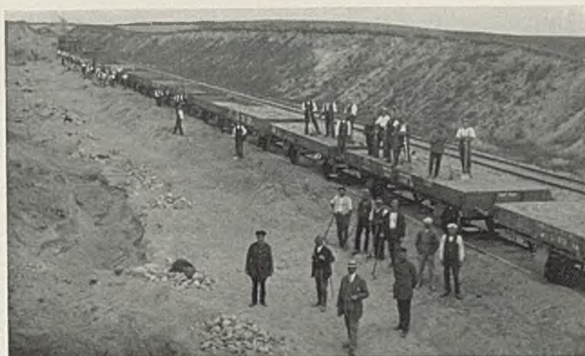
Kiesgrubenbetrieb in Jakobowo h. Gilgenburg. Verladung von Kies für die Reichseisenbahn auf eigenem Anschlußgleis. 1925
