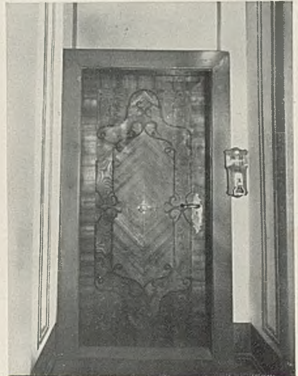
Tür aus dem Hause Schmiedestr. 11, mit reichen Intarsien. 1598. Schlüsselschild und Drücker aus späterer Zeit Phot. W. Zehr
