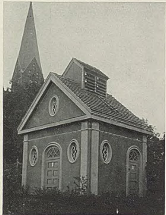
Städt. Transformatorstation Am Mühlendamm
