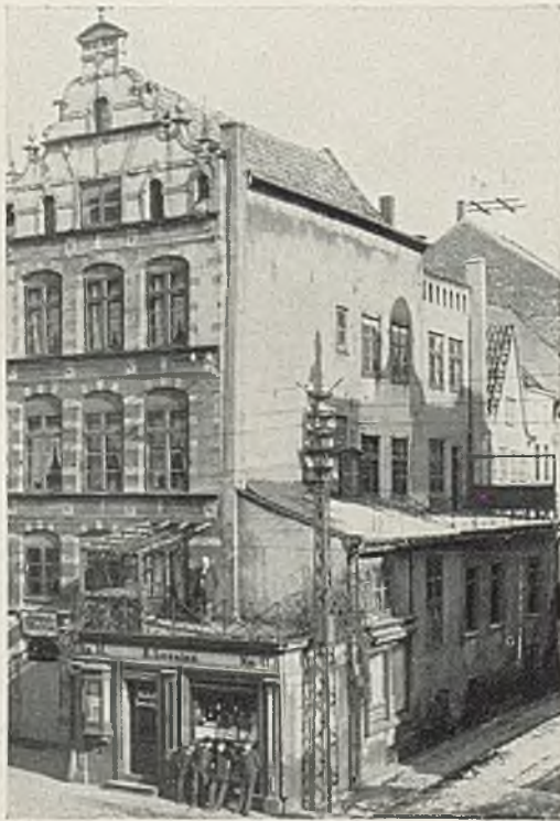
Alter Markt 51, Ecke Kettenbrunnenstraße, abgebrochen Phot. L. Basilius
