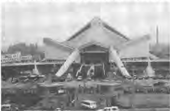
图 30-1 正在建设中的汉中体育馆
