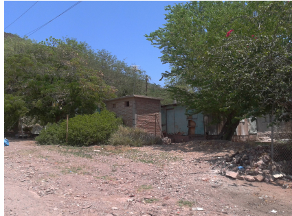
Fig. 6 Vivienda con saneamiento básico deficiente.
