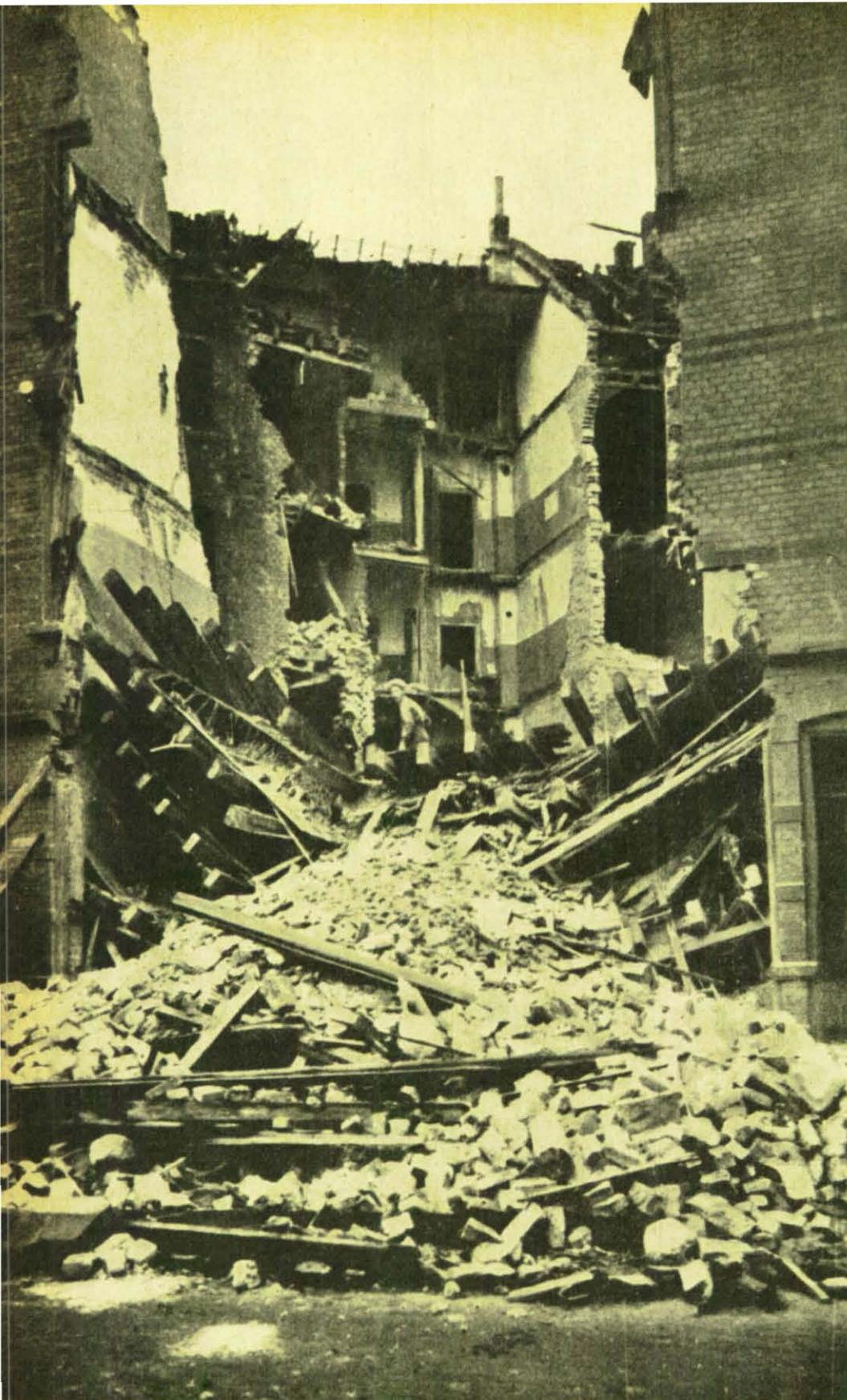
Typisches Wirkungsbild einer mittleren Sprengbombe aus dem zweiten Weltkrieg. Die Bombe durchschlug sämtliche Geschoßdecken bis zum Keller und riß das Haus von innen her auf.
