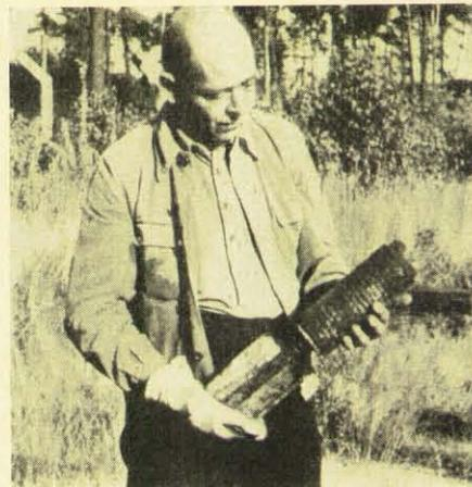
Leichte amerikanische Splitterbombe. Eine um den Bombenmantel gelegte 9 mm starke Stahlfeder zerspringt in viele kleine Splitter.
