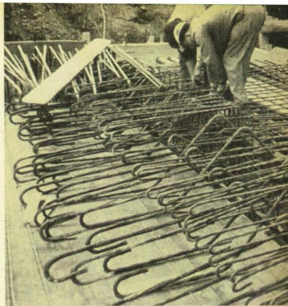
Nach dem Prinzip des biegesteifen Kastens ist der Musterschutzraum in Waldbröl angelegt. Während früher für Schutzräume nur eine besonders starke Decke gefordert wurde, bieten moderne Schutzräume nach allen Seiten einen gleich starken Widerstand.
