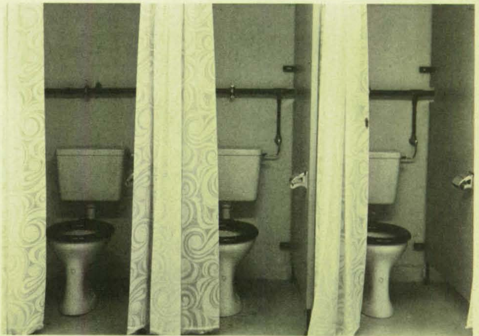
Durch den Ausfall von Generatoren fehlte auch Wasser in den Wasch- und Toilettenräumen.
