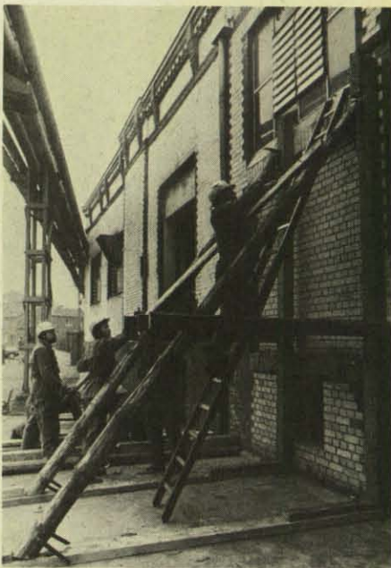
Abstützen einer einsturzgefährdeten Wand, lautete der Auftrag für die THW-Helfer.
