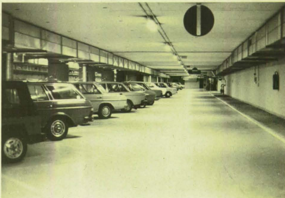
Die Mehrzweckanlage Stuttgart-Hauptbahnhof: Die übungsmäßige Umrüstung zum Schutzraum gestaltete sich schwierig, denn der Bettenaufbau war dadurch behindert, daß noch viele Personenkraftwagen auf der für die Betten vorgesehenen Parkfläche standen.
