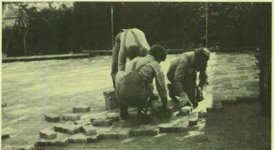
Schließlich war es geschafft: Nur noch wenige Quadratmeter von insgesamt 108 müssen verlegt werden!
