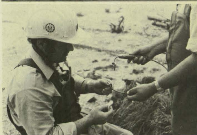
Sprengberechtigte des THW fertigen eine Ladung an.
