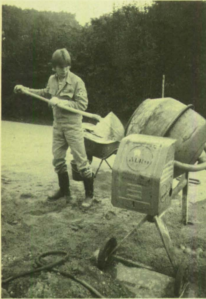
Eine andere Gruppe traf die Vorbereitung für die Pflasterung einer Hoffläche.
