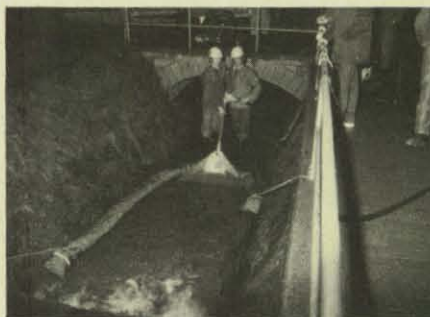
Als wirksame Maßnahme erwies sich der Bau einer Ölsperre im Bachlauf.
