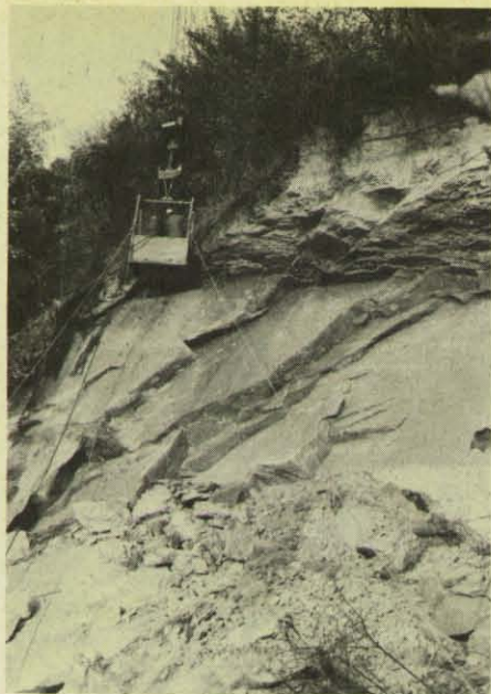
Von einer Arbeitsbühne aus wurden rund 50 Kubikmeter Gestein und Erde abgebaut.
